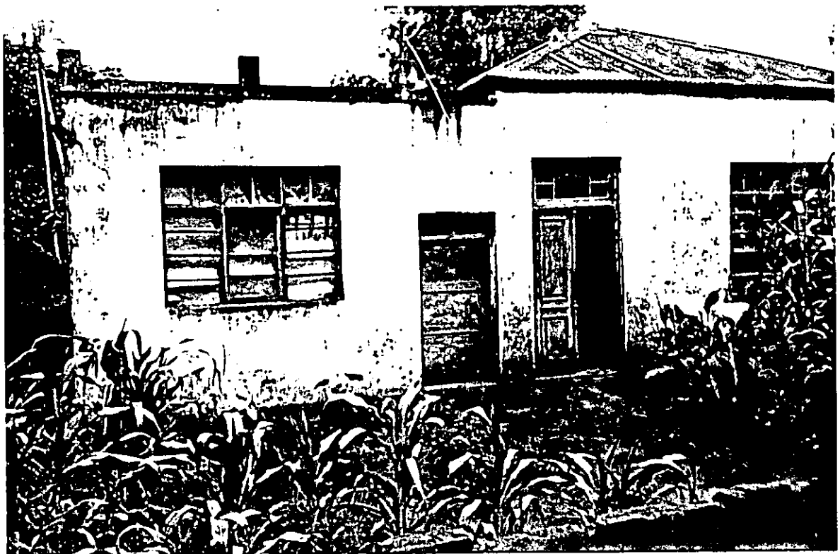
4. Degradação de imóveis (1996)
