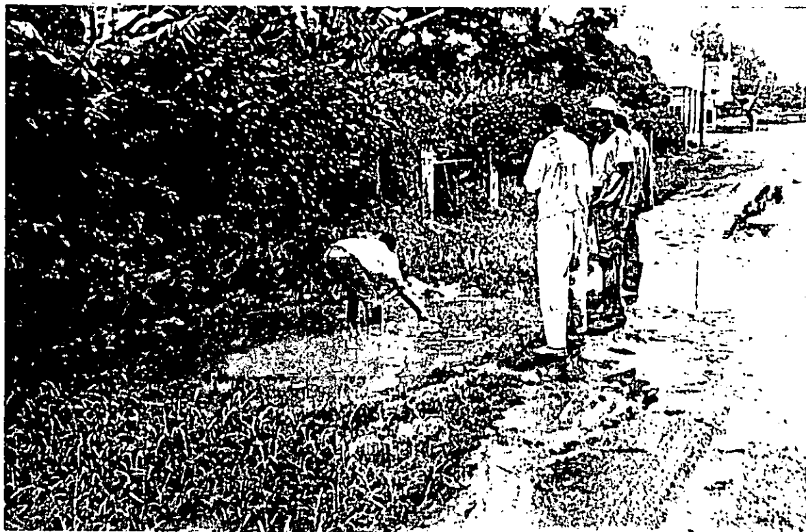
7. Desobstrução do sistema de saneamento
