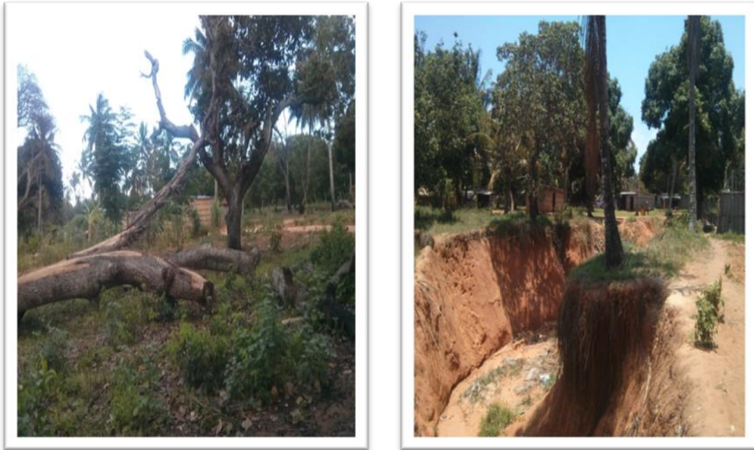
Figura nº 5: Agravamento da Erosão devido ao abate excessivo de Árvore
