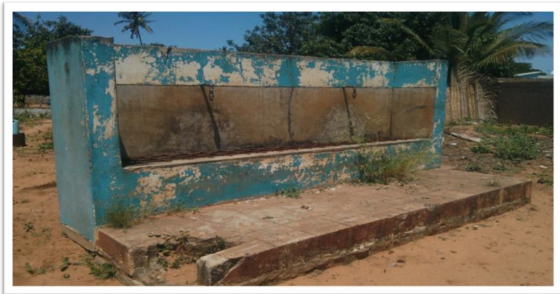
Figura nº 1: Fontenaria de Destribuição de Água Potavel avariada
