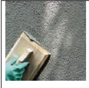
Fig. 4: cal + cimento + água
