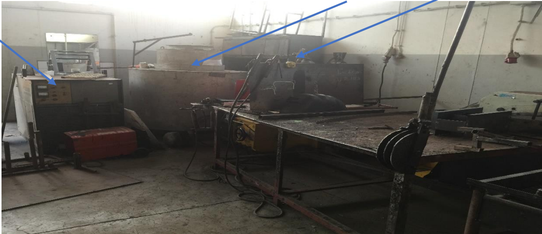
Imagem de parte dos equipamentos desusados encontrados na área onde funciona a secção de soldadura (6, 7 e 8)
