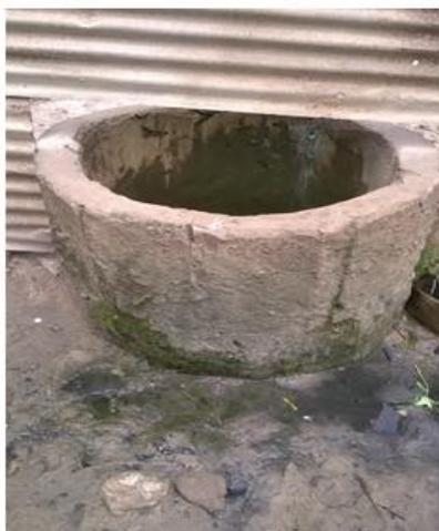
**Figura 21.** Ilustração do poço a menos de 15m da fossa.
