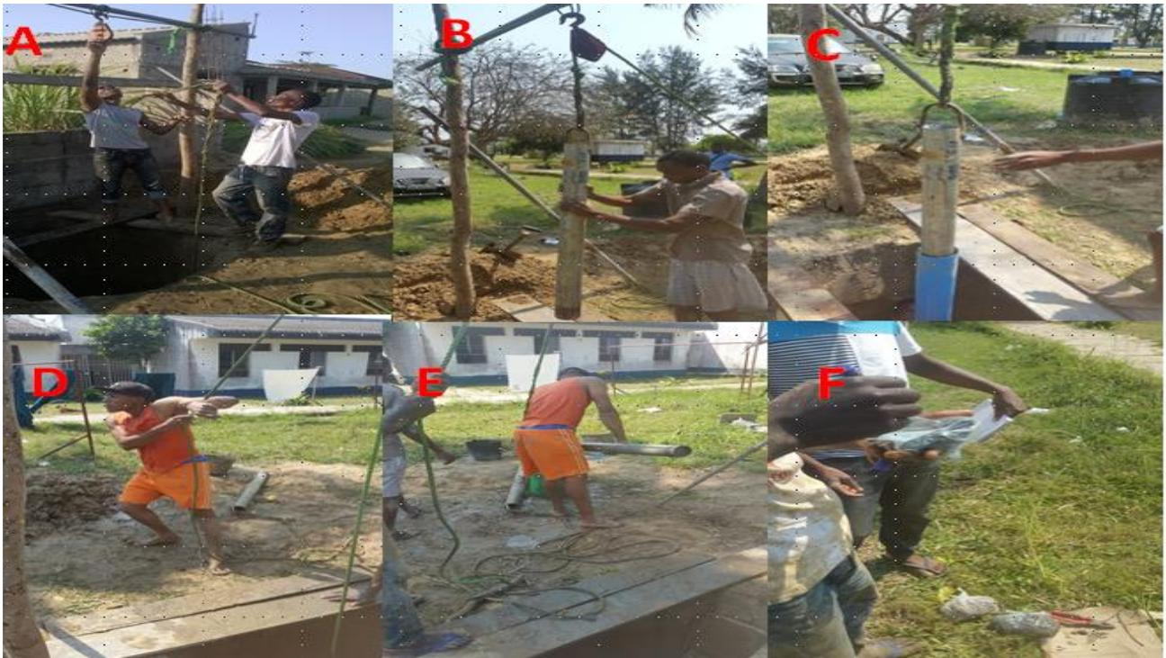
Imagem2:Abertura de furos de pesquisa. A- fixação de postes e roldana; B – Montagem da broca;
