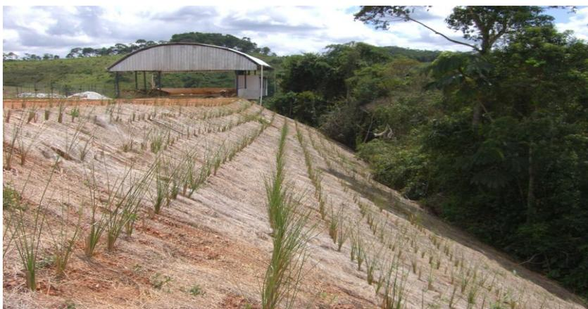
**Figura nº13: Grampeamento verde em aterro para estabilização de taludes**
