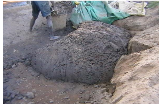
Fig 15:a) Massa homogeneizada com os pés b) Amassamento
