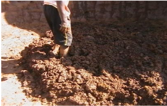
Fig 15:a) Massa homogeneizada com os pés b) Amassamento
