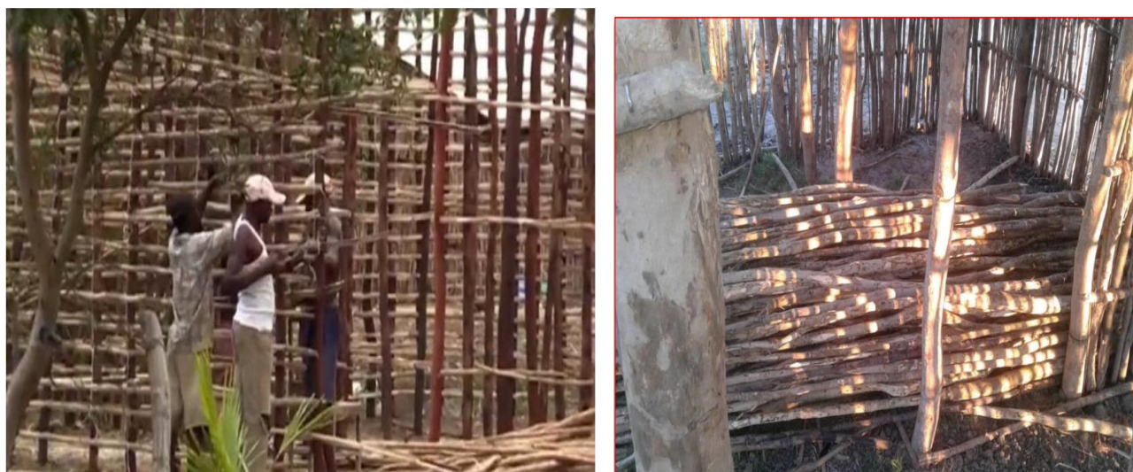
Figura 4. Construção de habitação a partir de estacas de mangal. Fonte: (Unaite, 2017).
