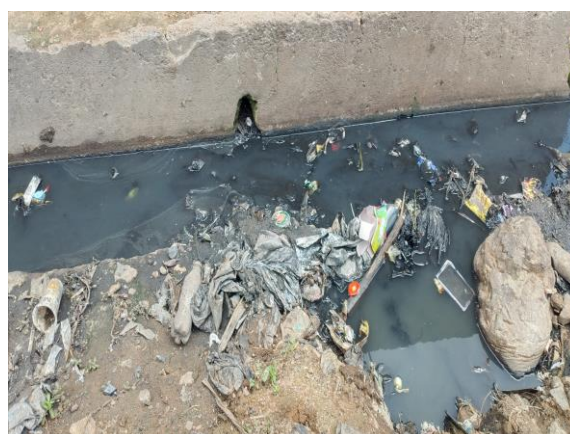
Figura 2: Presença de lixo nas valas
