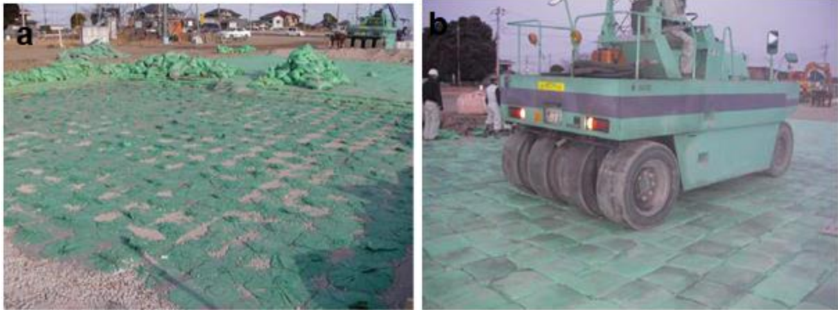
Foto 3: Soilbag : (a) Superfície superior do soilbag , (b) Compactação do soilbag com um compactador pneumático. Fonte: (Nomoto & Matsuoka, 2015).
