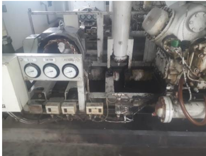
Fotografia 9: Desmontagem do motor eléctrico
