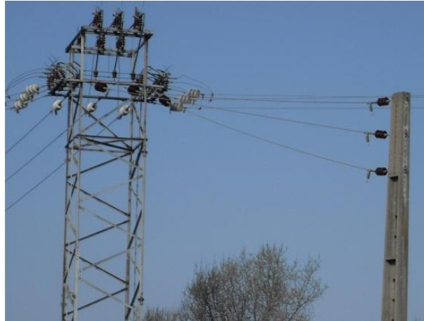
Figura 5: Apoio de metal sustentado por um apoio de betão
