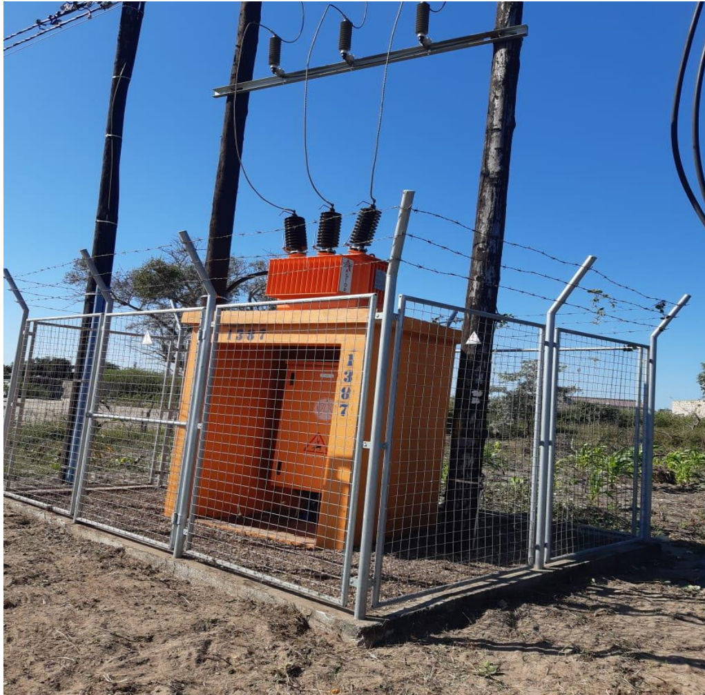
Figura 12: Instalação de um pára-raios de distribuição em estrutura de transformador
