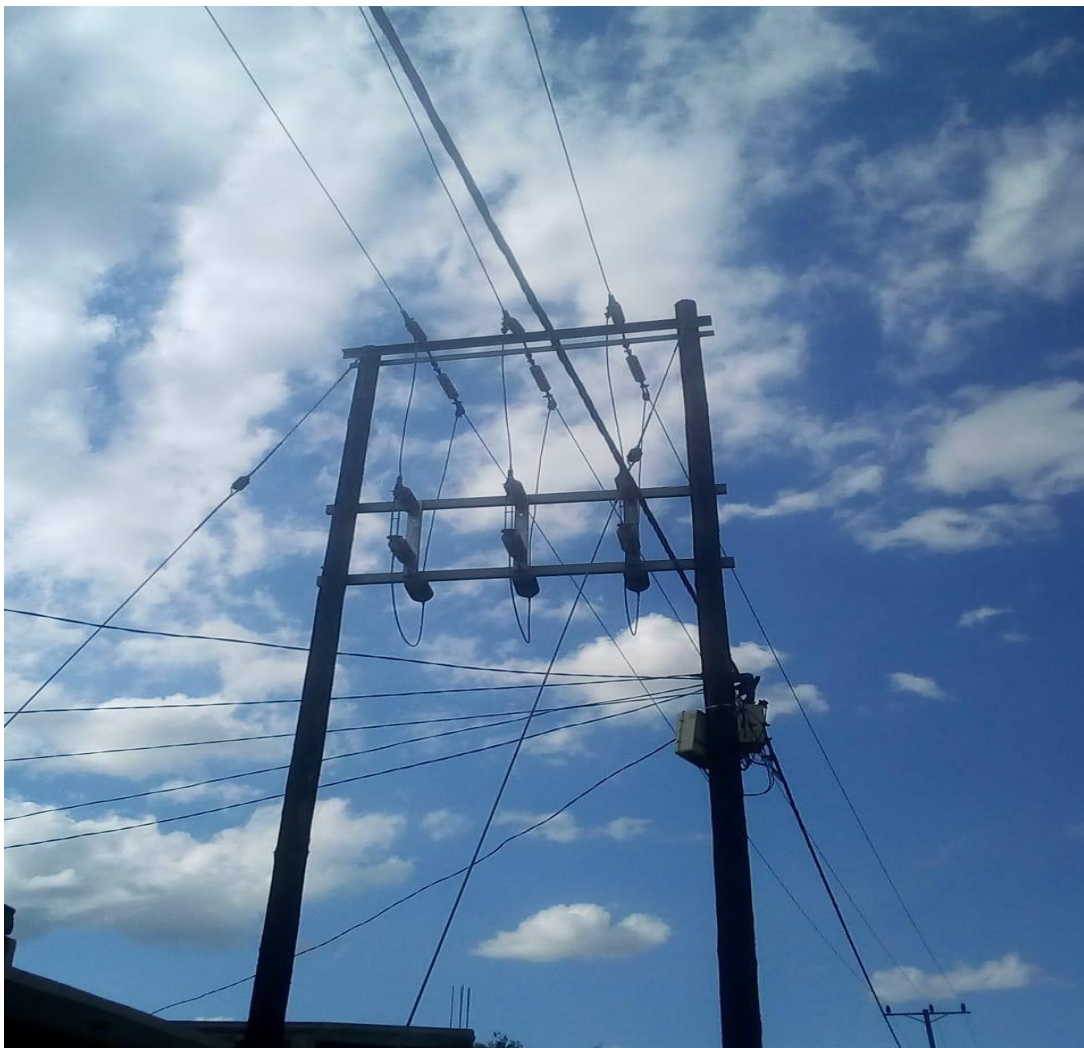
Figura 3: Linha de transmissão em estrutura de madeira
