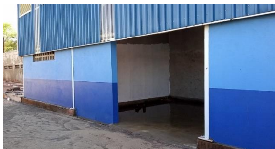
Figura 14: Localização de central de compressor.
