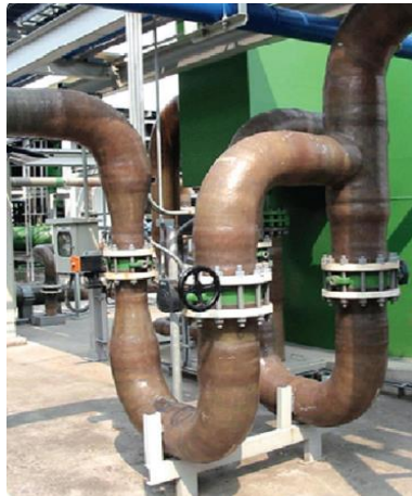
Figura 19: Tubulação de aço flangeada
