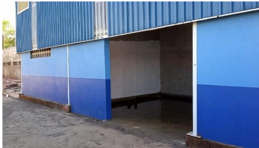
Figura 3: Localização de central de compressor
