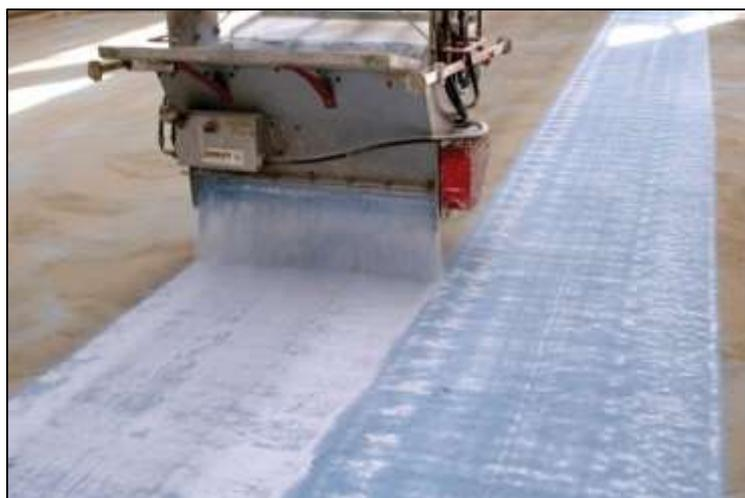
**Figura 18:** Endurecedor sólido à base de agregados minerais.<sup>22</sup>
