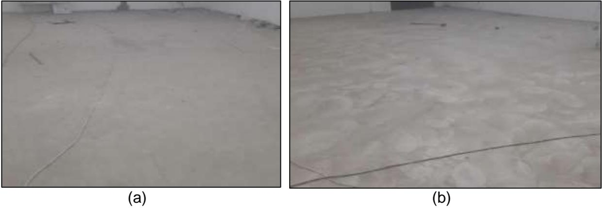
**Figura 45:** Superfície da base antes da preparação (a); Superfície da base depois da preparação (b).
