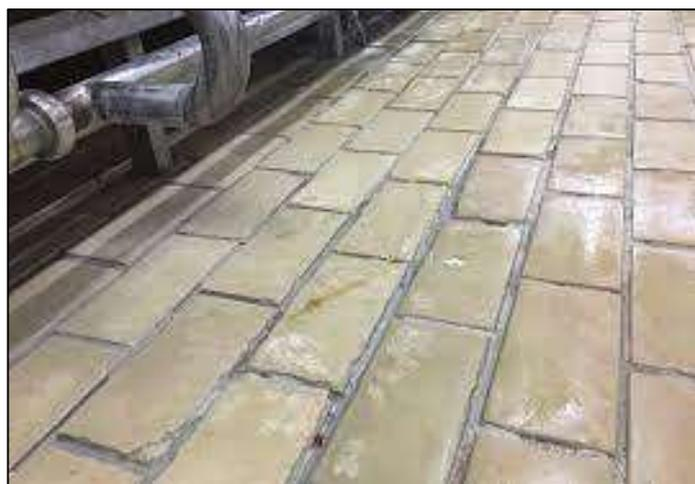
**Figura 29: Ataques ácidos em revestimentos cerâmicos.**
