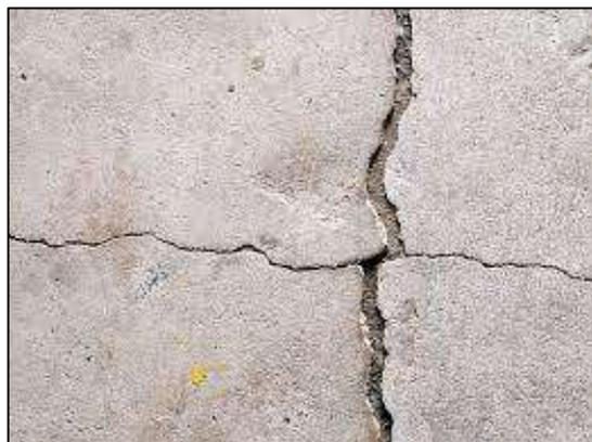
**Figura 24:** Retração em pavimentos industriais.<sup>31</sup>
