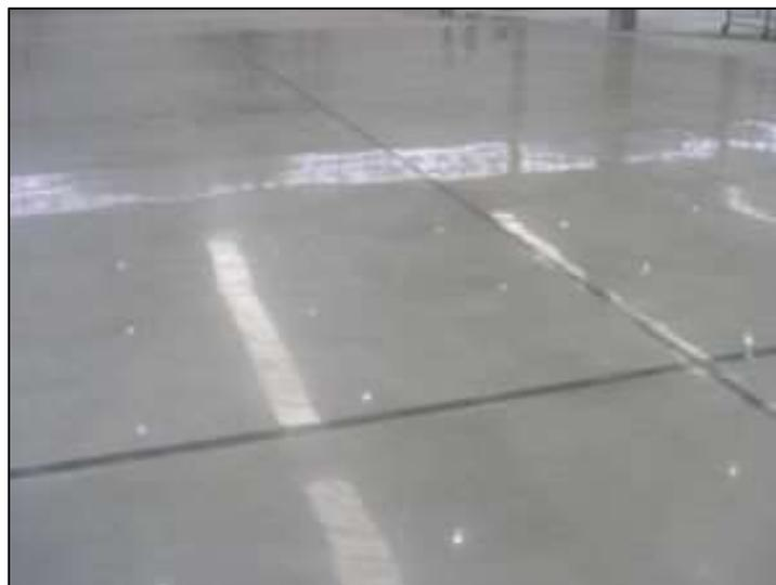
**Figura 16:** Pavimento revestimento com endurecedor de superfície.<sup>20</sup>
