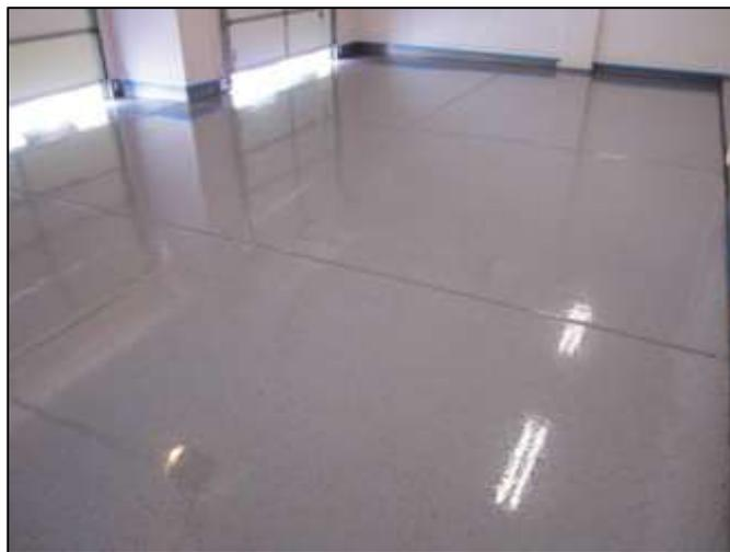
Figura 22: Revestimento à base da resina epóxi.<sup>28</sup>
