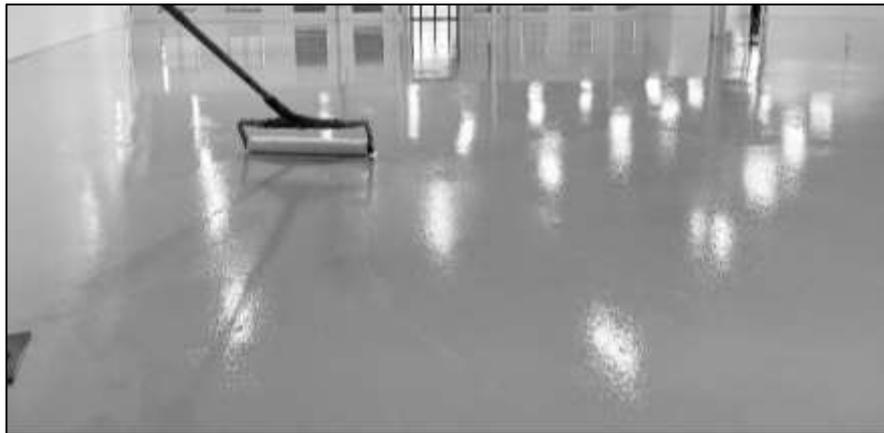
**Figura 44:** Aplicação do pavimento epóxi. <sup>53</sup>
