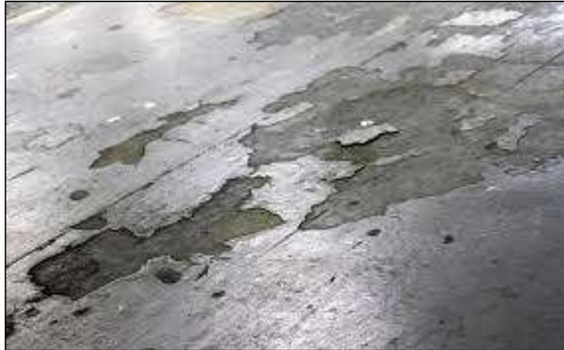
**Figura 32: Danificação do pavimento pelo efeito de abrasão.**
