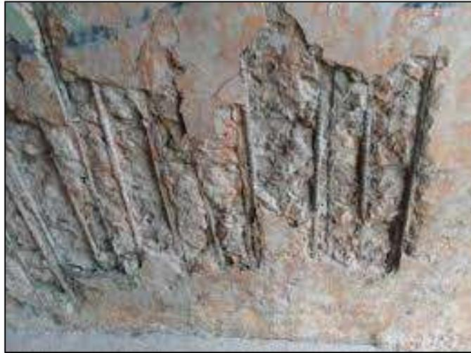
**Figura 28: Superfície de betão que sofreu ataque químico - desgaste.**
