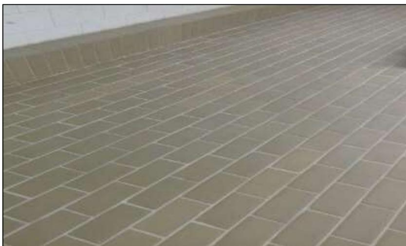
**Figura 20: Revestimento com cerâmica antiácida.**<sup>26</sup>
