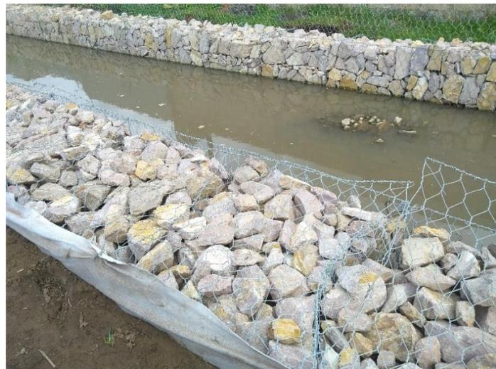
Foto 11 – Aplicação da manta geotêxtil e aterro
