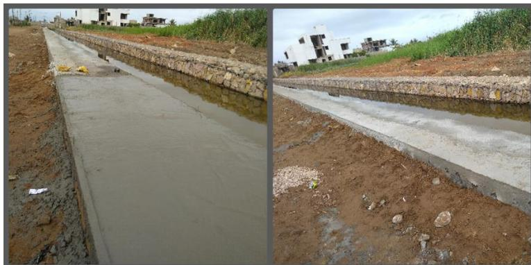
Foto 15 - Cura e retirada da cofragem
