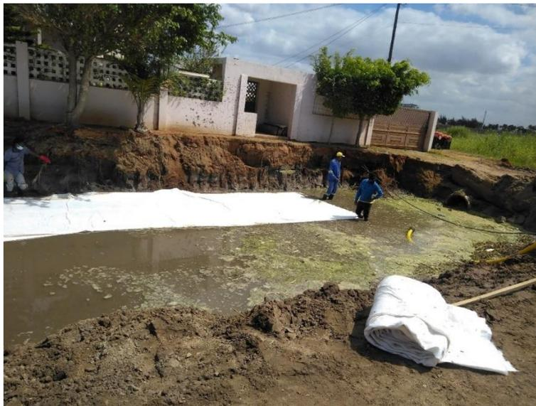
*Foto 3 – Instalação da Manta Geotêxtil no fundo da Vala*
