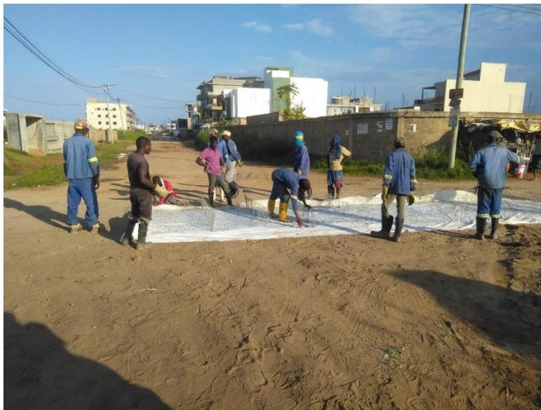
*Foto 4 – União da Manta Geotêxtil com o colchão Reno*
