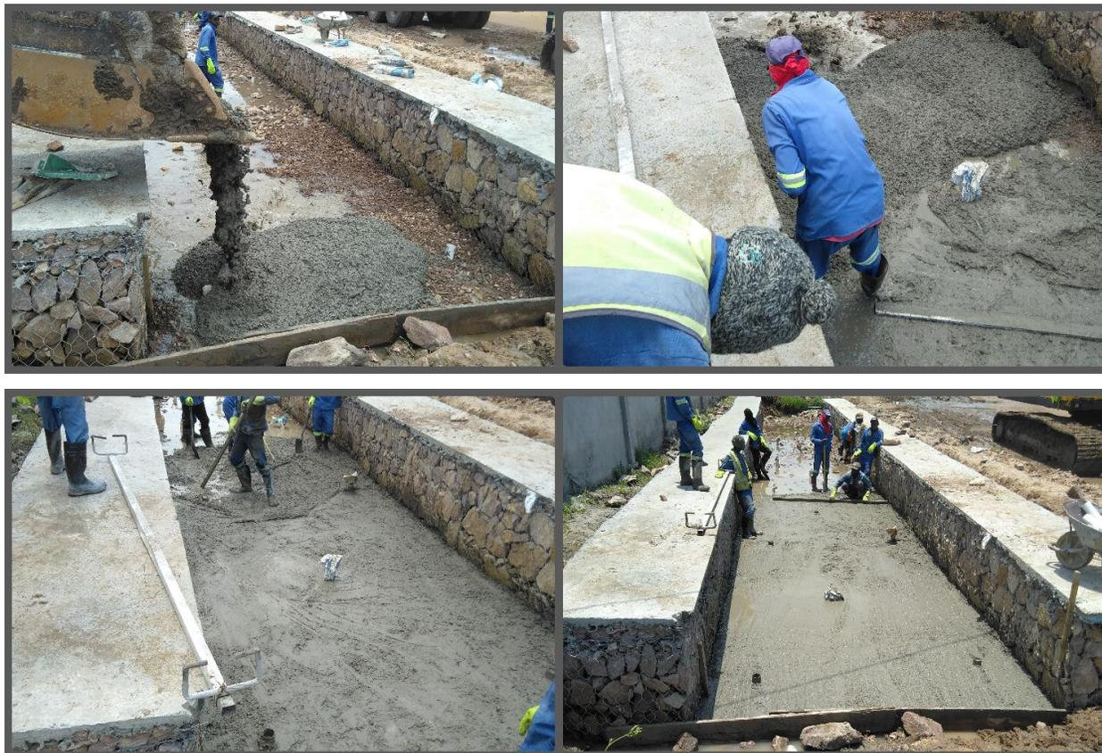
Foto 20 – Betonagem
