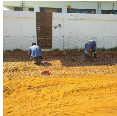
Foto 8 – Montagem das box's para os muros da vala
