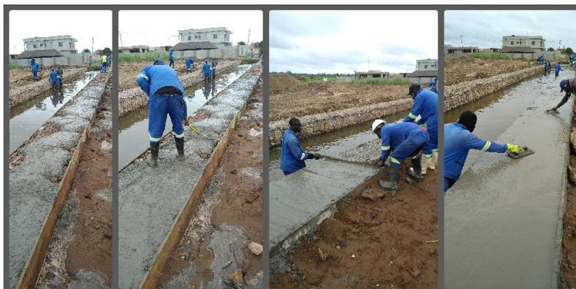
Foto 14 – Betonagem e nivelamento
