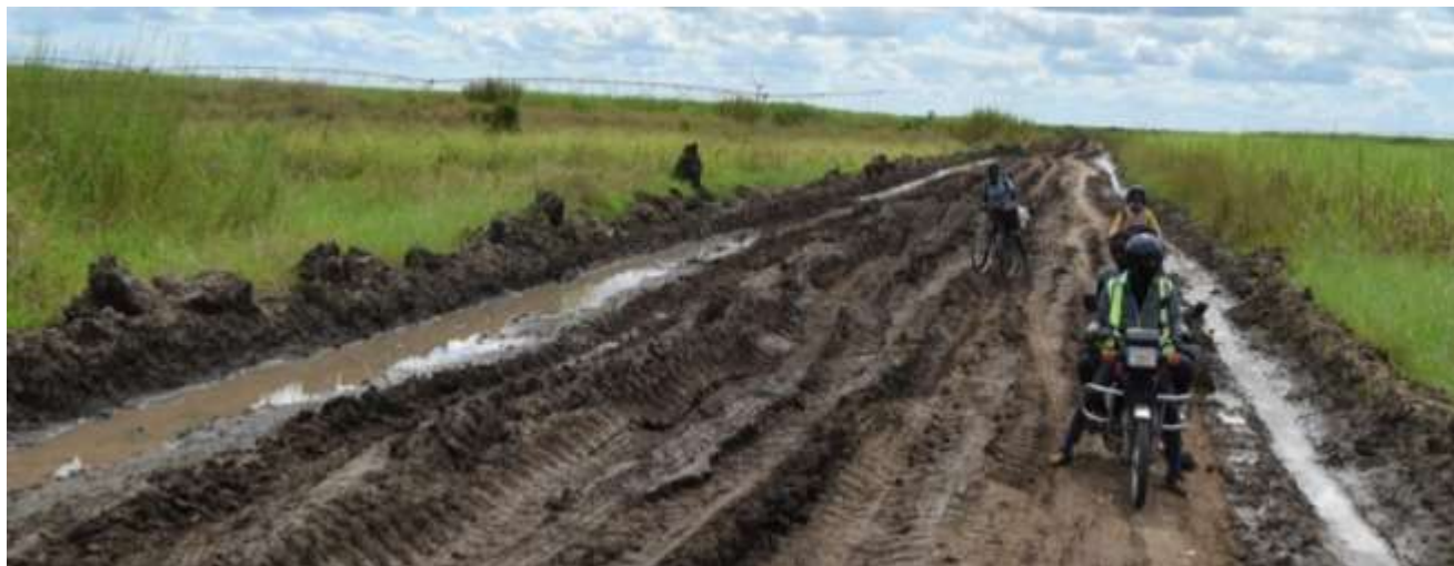
Foto 1: Estado da via de acesso à RNM na época chuvosa
