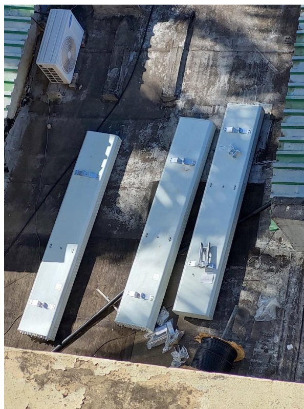
Figura do anexo XIV- Novas antenas sectoriais (do autor)
