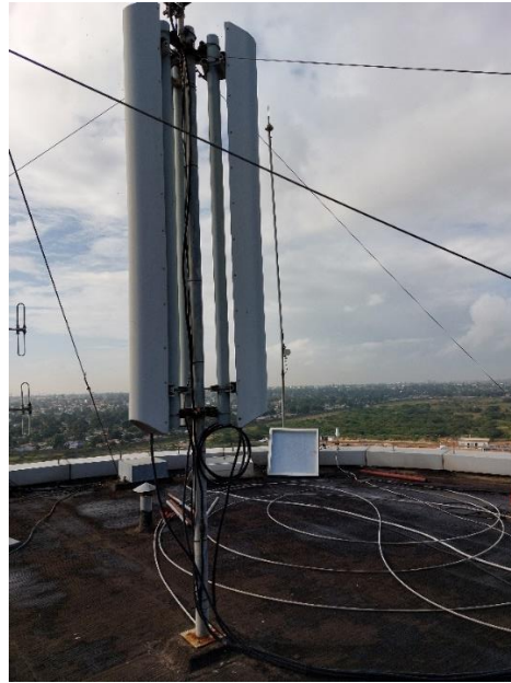
Figura 15- Antenas do ADS-B (do autor)
