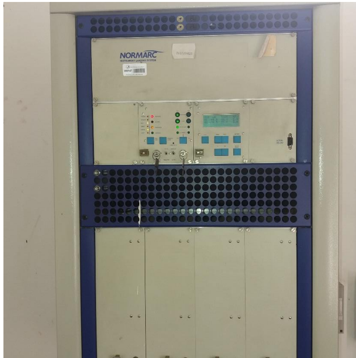
Figura do anexo III- Estação monitora do LLZ (do autor)
