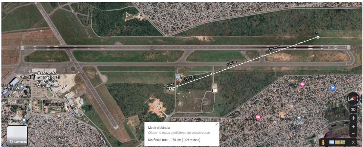
Figura 19- Distância da nova torre ao GP (Google maps)
