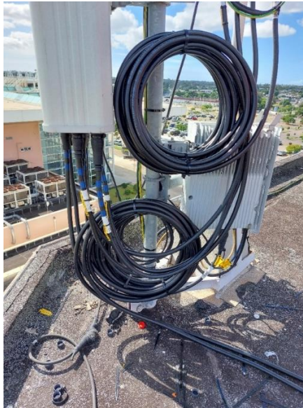
Figura 12- Antena sectorial e rru (do autor)
