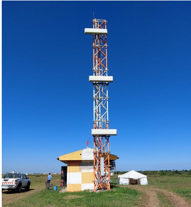
Figura do anexo VI- Antenas do GP (do autor)
