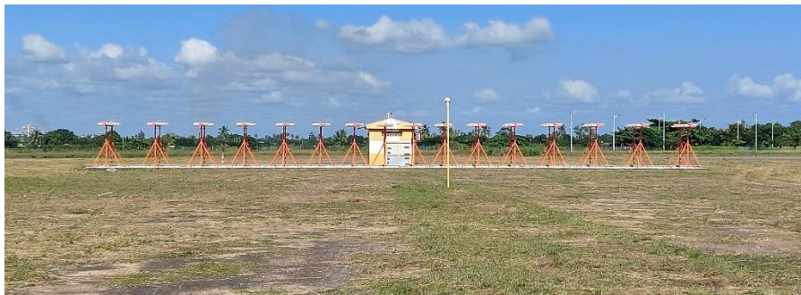
Figura 6- Arranjo de antenas do LLZ (do autor)
