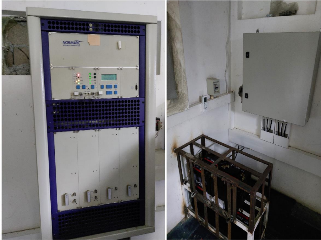
Figura do anexo V- Estação monitora do GP (do autor)
