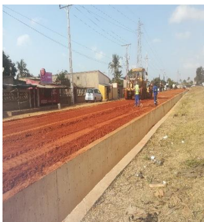
Figura 15: Mistura de solos Vermelhos; Figura 16: Compactação da sub-base; Figura 17: Sub-base compactação
