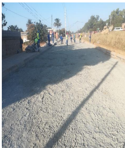
Figura 24: Espalhamento manual completo;
