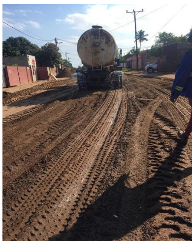
Figura 10: Escarificação do Subleito Figura 11: Regularização Figura 12: Rega do subleito
