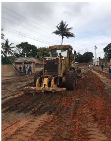
Figura 10: Escarificação do Subleito Figura 11: Regularização Figura 12: Rega do subleito
