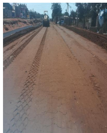
Figura 15: Mistura de solos Vermelhos; Figura 16: Compactação da sub-base; Figura 17: Sub-base compactação
