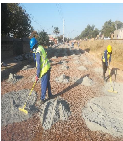
Figura 23: Processo de espalhamento manual ;
