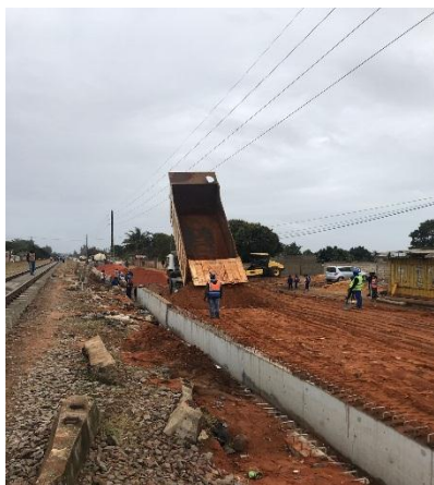
Figura 14: Fornecimento de solos vermelhos para sub-base;
