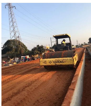
Figura 15: Mistura de solos Vermelhos; Figura 16: Compactação da sub-base; Figura 17: Sub-base compactação
