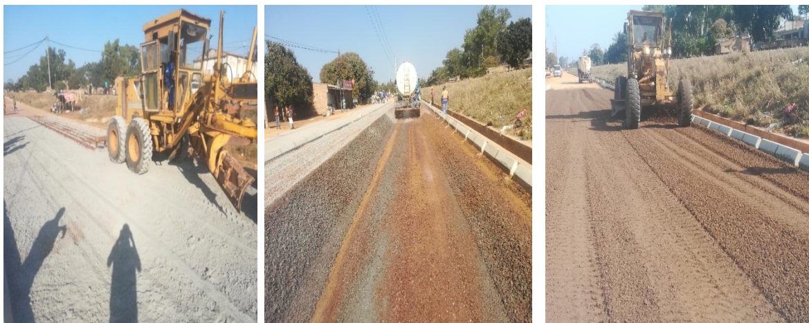
Figura 25 Processo de Mistura; Figura 26: Régua da Mistura; Figura 27 : Espalhamento da Mistura;
