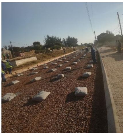
Figura 22: Distribuição dos sacos de cimento para mistura;
