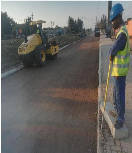
Figura 28: Compactação da base com cilindro compactador; Figura 29: Teste de da Base Com Troxler
