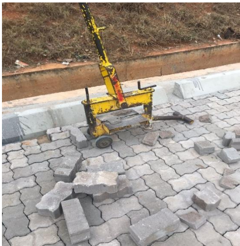
Figura 31: Assentamento de Pavê 8,00 cm;
