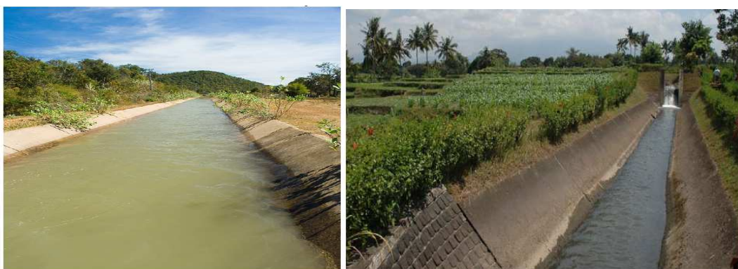
Figura 9: Conduto Aberto com Formato Trapezoidal
