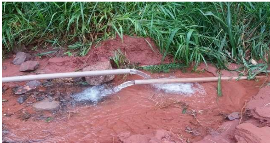
Figura 4: Sistemas de Abastecimento de Água deficientes
