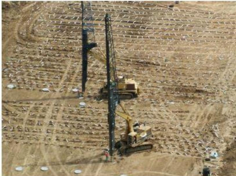
**Figura A.2-3: Instalação de drenos pré-fabricados.**
