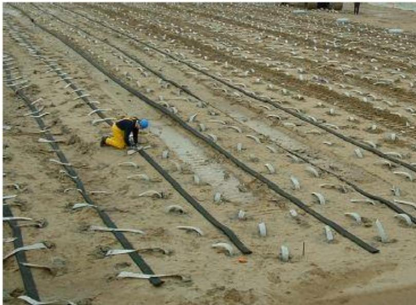
**Figura A.2-4: Drenos verticais pré-fabricados conectados ao sistema de descarga.**
