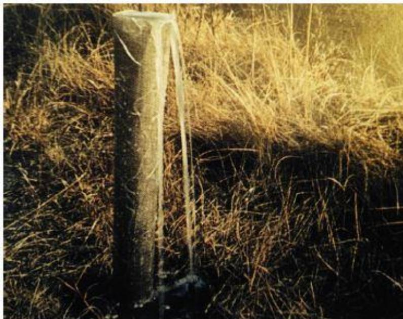
**Figura A.2-2: Exemplo de descarga de um dreno pré-fabricado.**
