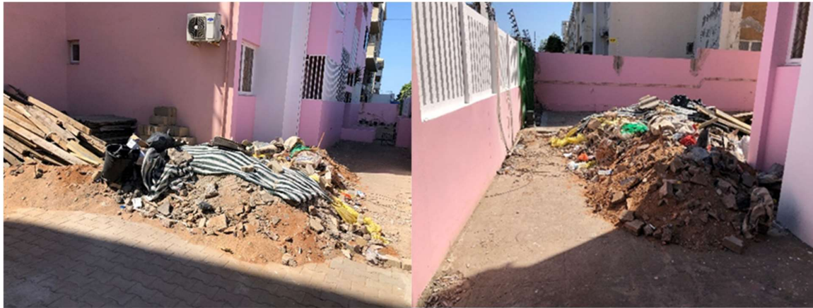
Figura 6. Armazenamento temporário dos resíduos
