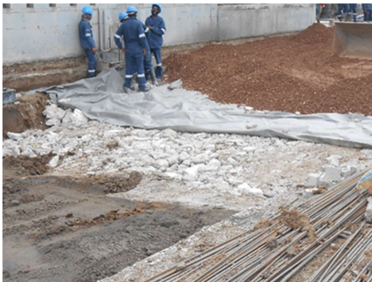
Figura 22. Reutilização de entulho para execução de pavimento
