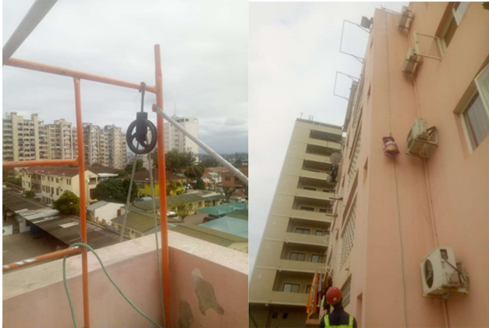
Figura 5. Transporte vertical dos resíduos na obra
