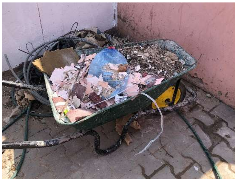
Figura 18. Acondicionamento inicial do revestimento e lixas
