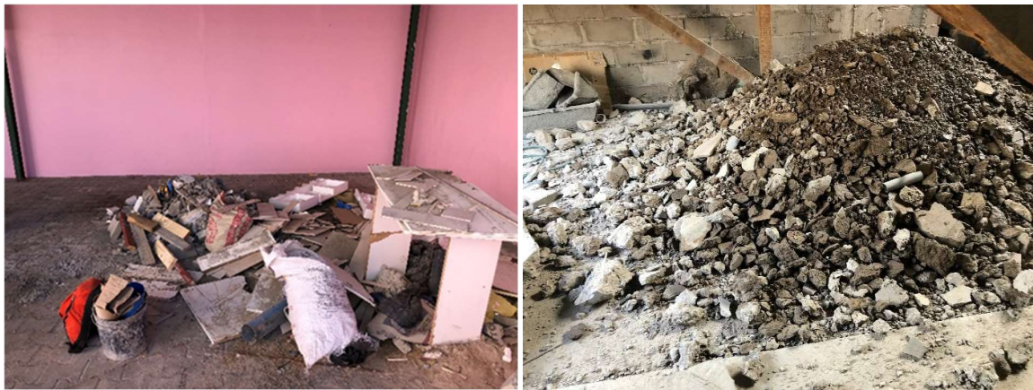
Figura 4. Acondicionamento inicial dos resíduos na obra
