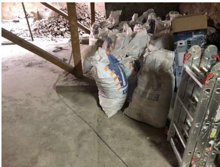
Figura 21. Acondicionamento inicial do entulho em sacos
