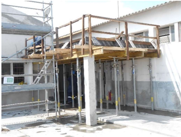
Figura 23. Reutilização da madeira para cofragem
