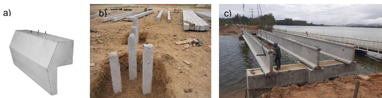
Figura 2.1: Elementos de betão pré-fabricado para pontes. a) Viga de bordadura b) Estacas de fundação c) Vigas de tabuleiro. Fonte: aclweb, concredol e notícias in foco.
