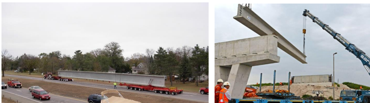
Figura 2.2: Transporte e posicionamento de vigas pré-fabricadas. Fonte: MnDOT e BFTInternational.
