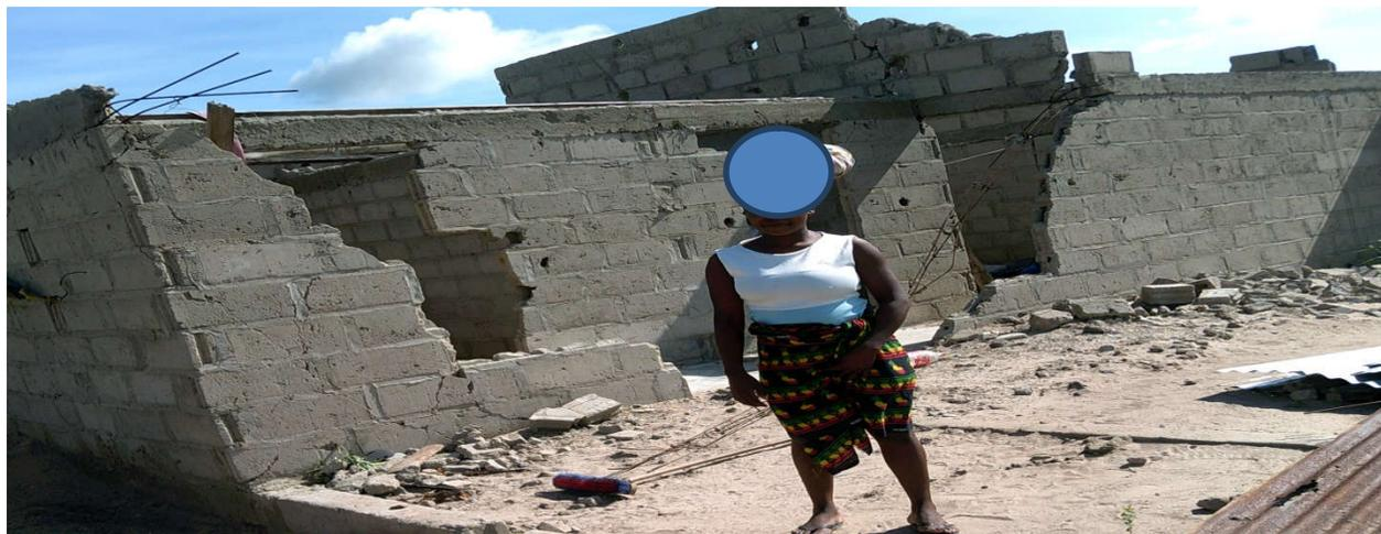
Figura 4.1: Desabamento de algumas paredes da casa e do tecto.
