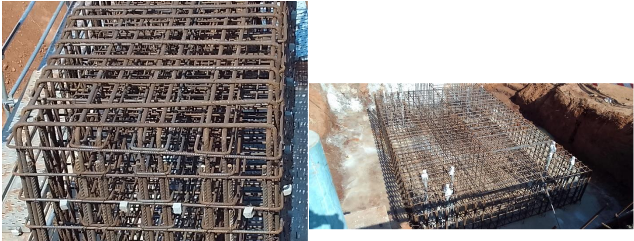
Figure 1: Armadura de reforço nos pilares e Armadura do maciço (Fonte: Autor)
