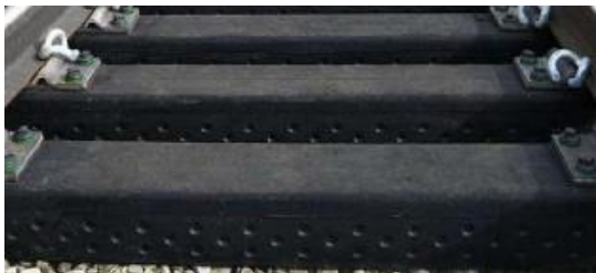
Figura 5: Travessa de material compósito
