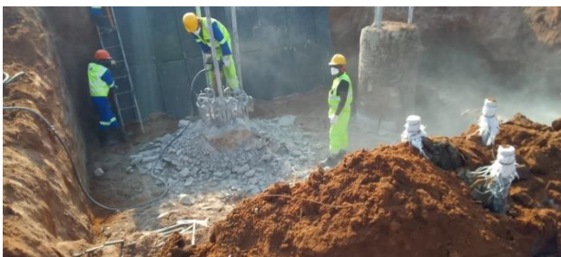
Figure 4: Saneamento de estacas
