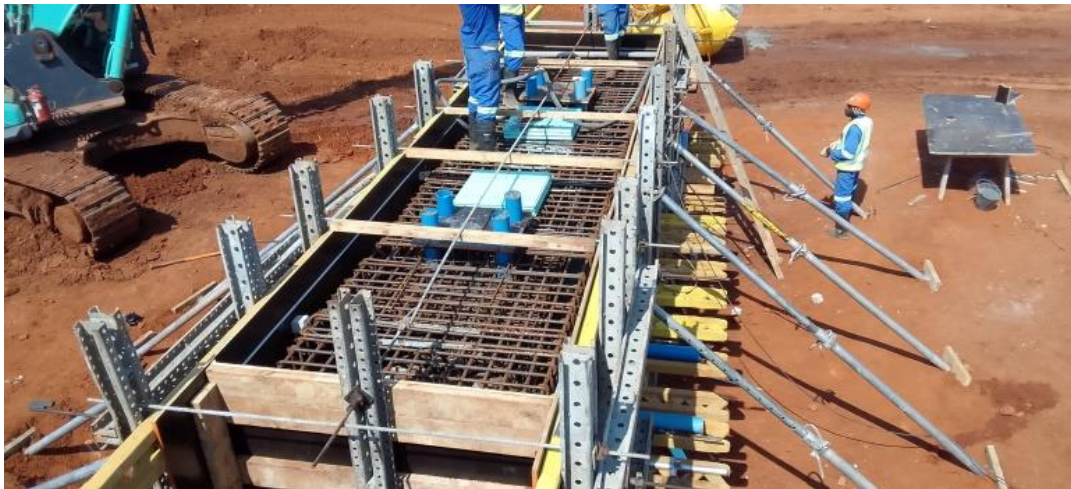
Figura 10: Cofragem de um pilar prestes a ser betonado. (Fonte: Autor)
