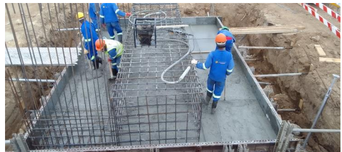
Figure 5: Betonagem do maciço de encabeçamento (fonte autor)
