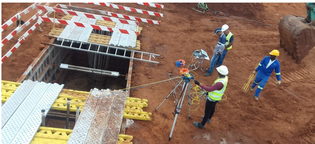
Figura 11: Ensaio de Crosse hole. (Fonte: Autor)
