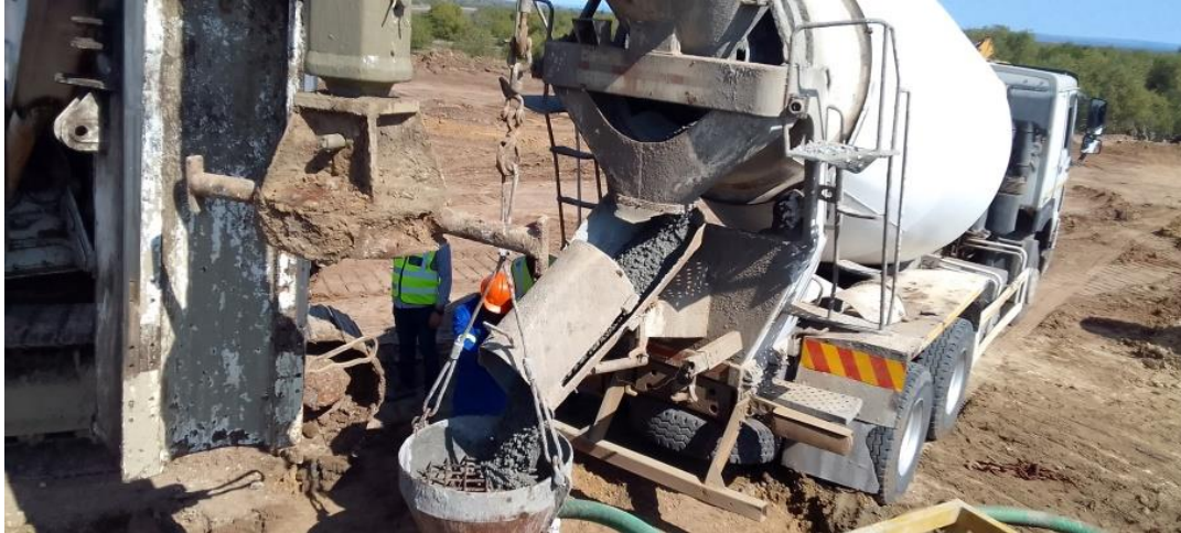
Figura 8: Betonagem das estacas (Fonte: Autor)
