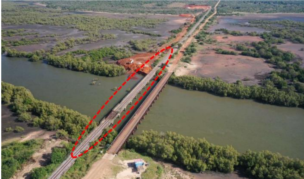
Figura 1: Vista aérea do local de implantação da ponte. (Fonte: F. Romão)
