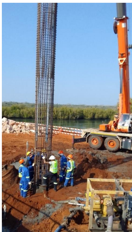
Figura 7: Colocação da armadura da estaca (Fonte: Autor)
