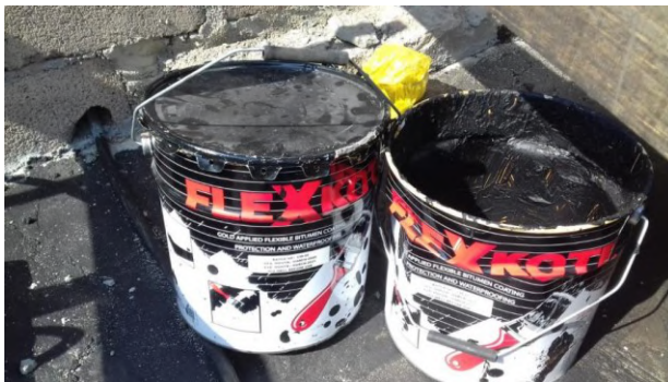
Figura 44. Alfato de impermeabilização
