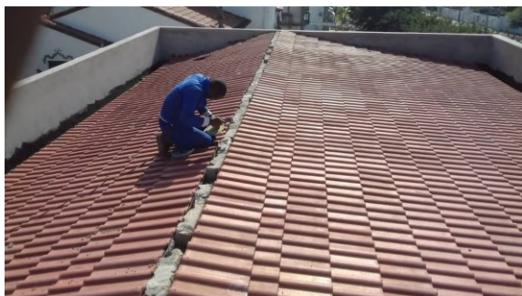
Figura 48. Colocação de telhas (fonte: Autor)
