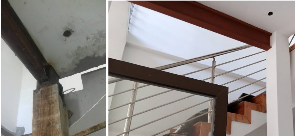
Figura 26. Revestimento do pilar metálico (1); Pilar metálico revestido (2) (fonte: Autor)
