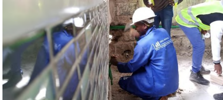
Figura 49. Instalação hidráulica (fonte: Autor)
