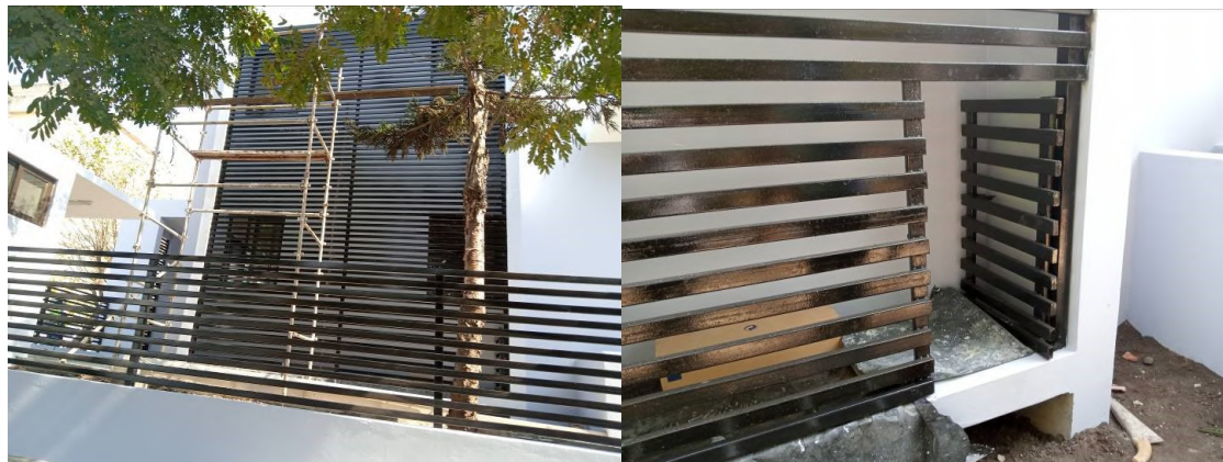
Figura 39. Vedação em perfis metálicos (1); Quebra-sol em perfis metálicos (2) (fonte: Autor)
