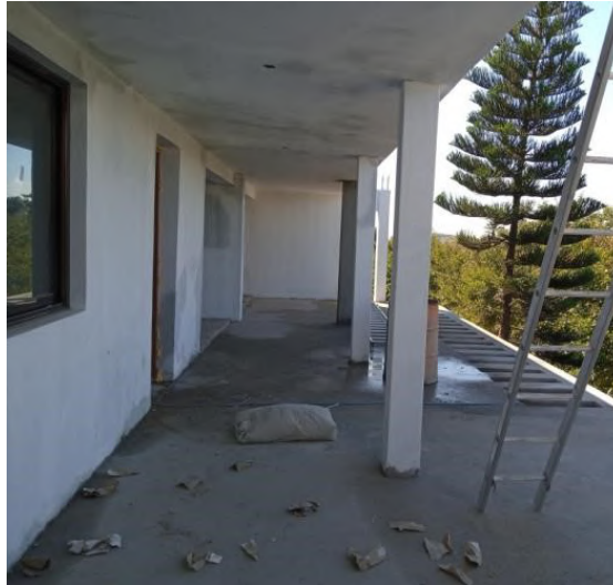
Figura 28. Revestimento dos pilares metálicos (fonte: Autor)
