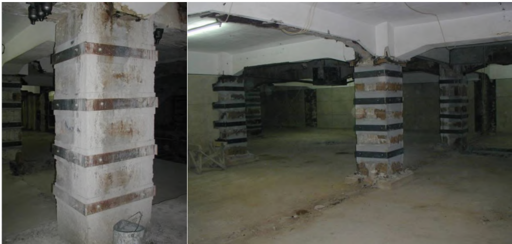
Figura 4. Reforço da cintagem dos pilares existentes com chapas metálicas (Appleton, 2014)
