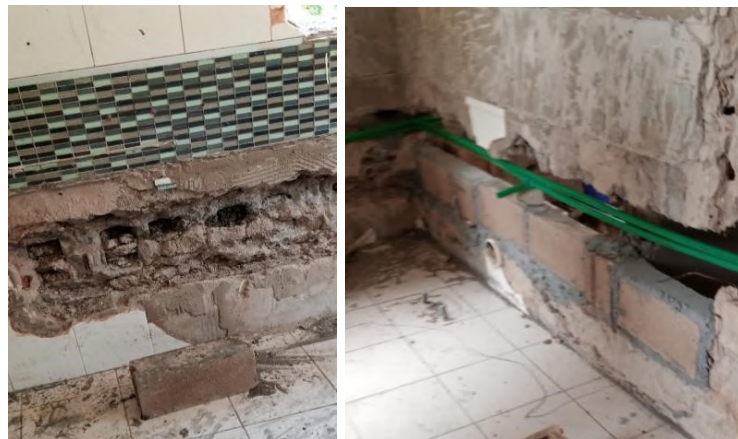
Figura 50. Abertura de roços (1); Colocação de tubagens (2) (fonte: Autor)
