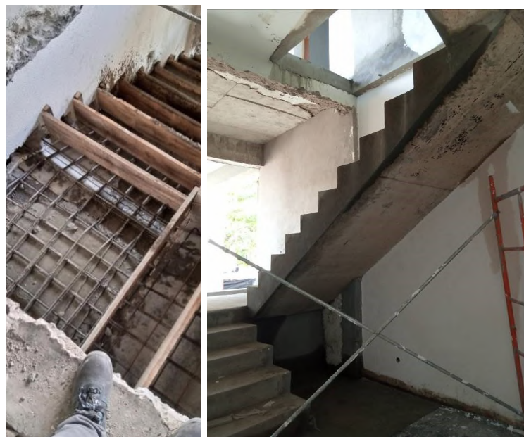
Figura 23. Cofragem de escadas (1); Betão de escadas curado (2) (fonte: Autor)
