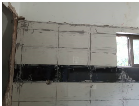
Figura 32. Colocação de azulejos (fonte: Autor)
