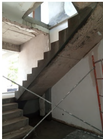
Figura 59. Escadas executadas (fonte: Autor)
