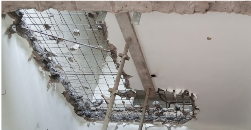
Figura 60. Prumos em laje demolida parcialmente (fonte: Autor)
