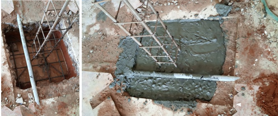
Figura 22. Abertura e colocação de armaduras (1); Colocação de betão nas sapatas (2) (fonte: Autor)
