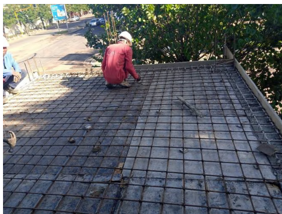
Figura 20. Armação de laje (fonte: Autor)
