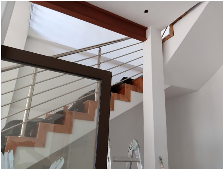
Figura 11. Escadas (fonte: Autor)
