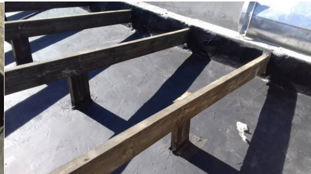
Figura 45. Impermeabilização da laje de cobertura
