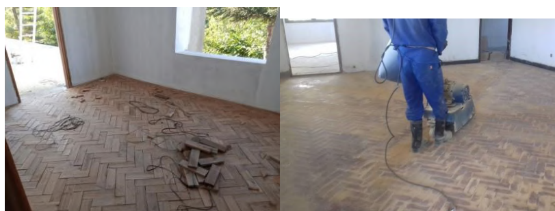
Figura 35. Assentamento de parquet (1); Afagamento de parquet (2) (fonte: Autor)
