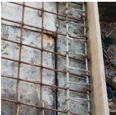
Figura 19. Viga parcialmente betonada (fonte: Autor)
