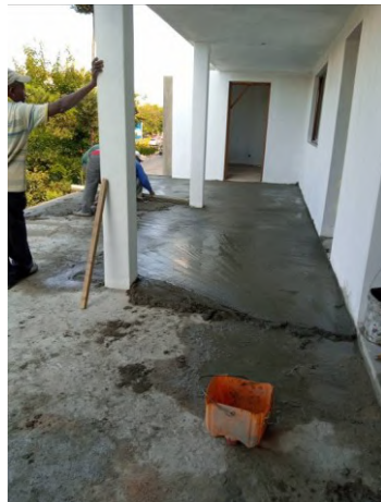
Figura 34. Aplicação de betonilha (fonte: Autor)
