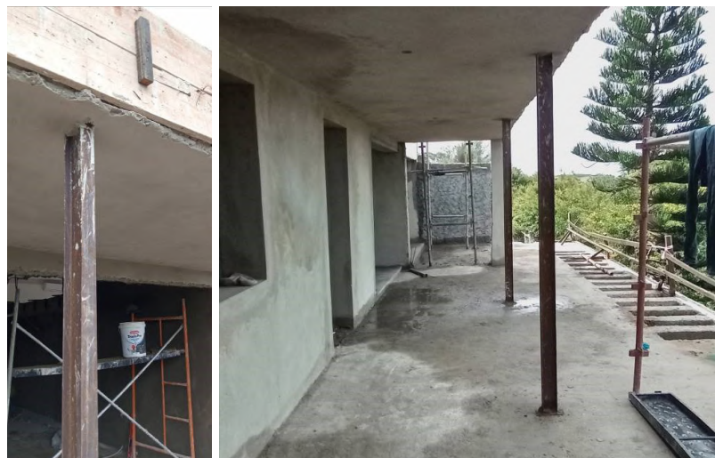
Figura 27. Pilares metálicos de reforço (fonte: Autor)
