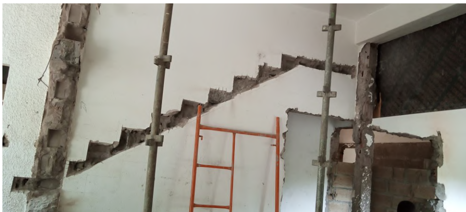
Figura 52. Local das futuras escadas (fonte: Autor)
