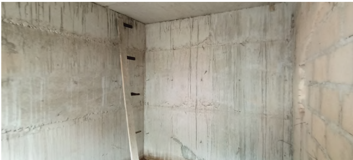
Figura 17. Parede em betão armado (fonte: Autor)
