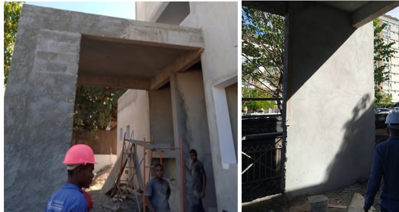
Figura 30. Chapisco (1); Reboco (2) (fonte: Autor)
