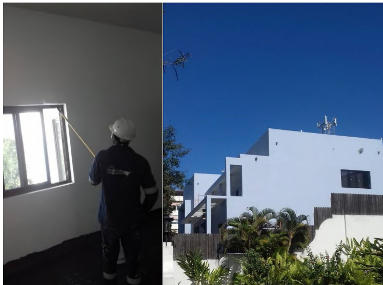
Figura 33. Pintura de parede interior (1); Pintura de fachadas (2) (fonte: Autor)
