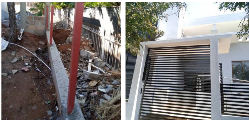
Figura 41. Colocação de mastros (1); Portão metálico (2) (fonte: Autor)
