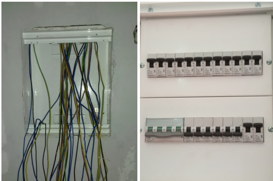
Figura 51. Montagem do quadro eléctrico (1); Quadro eléctrico instalado (2) (fonte: Autor)
