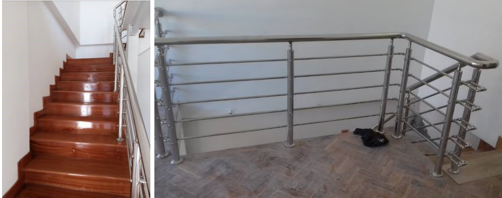
Figura 24. Revestimento de escadas (1); Guarda-corpos de alumínio (2) (fonte: Autor)
