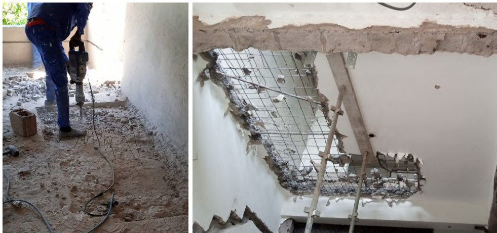
Figura 25. Demolição da laje com martelo eléctrico (1); laje demolida parcialmente (2) (fonte: Autor)
