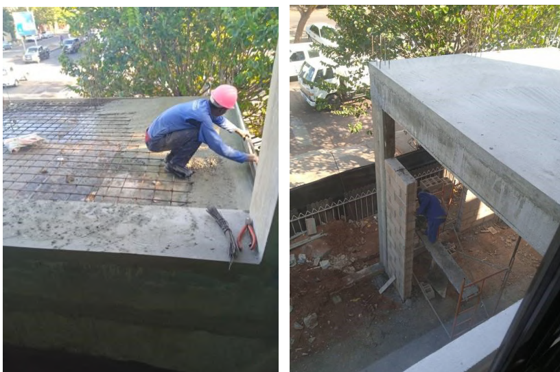
Figura 21. Colocação do betão (1); Betão curado (2) (fonte: Autor)
