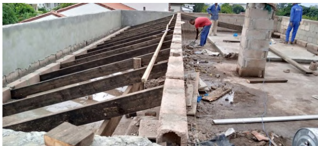
Figura 46. Asnas da cobertura (fonte: Autor) Autor)
