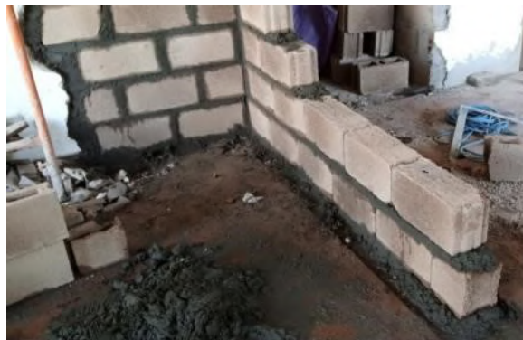
Figura 29. Alvenaria em blocos de cimento (fonte: Autor)
