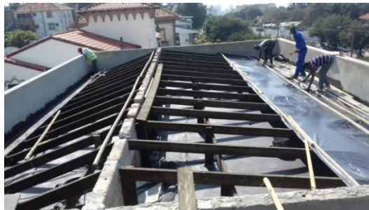
Figura 47. Colocação de plástico na cobertura (fonte: Autor)
