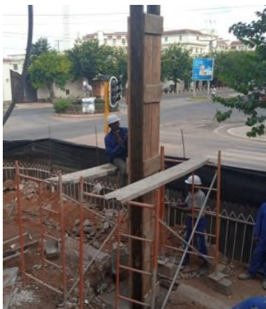
Figura 18. Cofragem de pilares (fonte: Autor)
