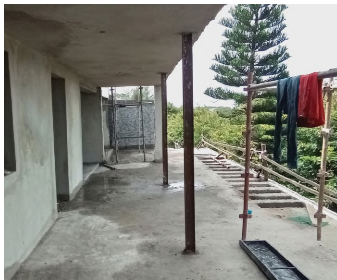
Figura 12. Reforço em pilares metálicos da laje da varanda principal (fonte: Autor)
