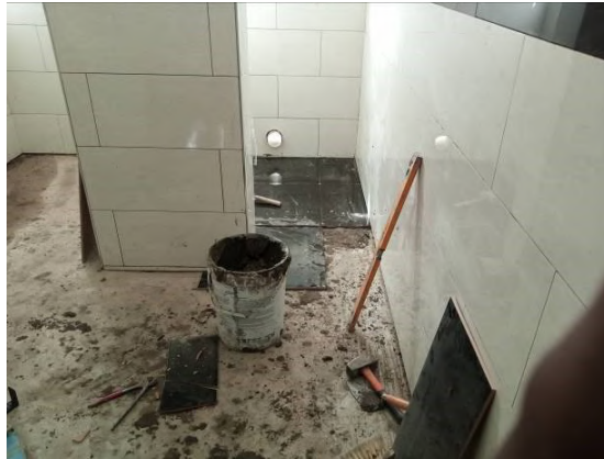
Figura 37. Colocação de piso cerâmico (fonte: Autor)
