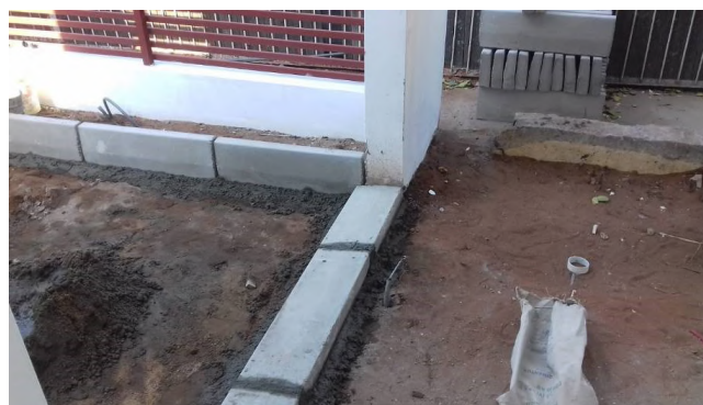
Figura 38. Colocação de pavês (fonte: Autor)
