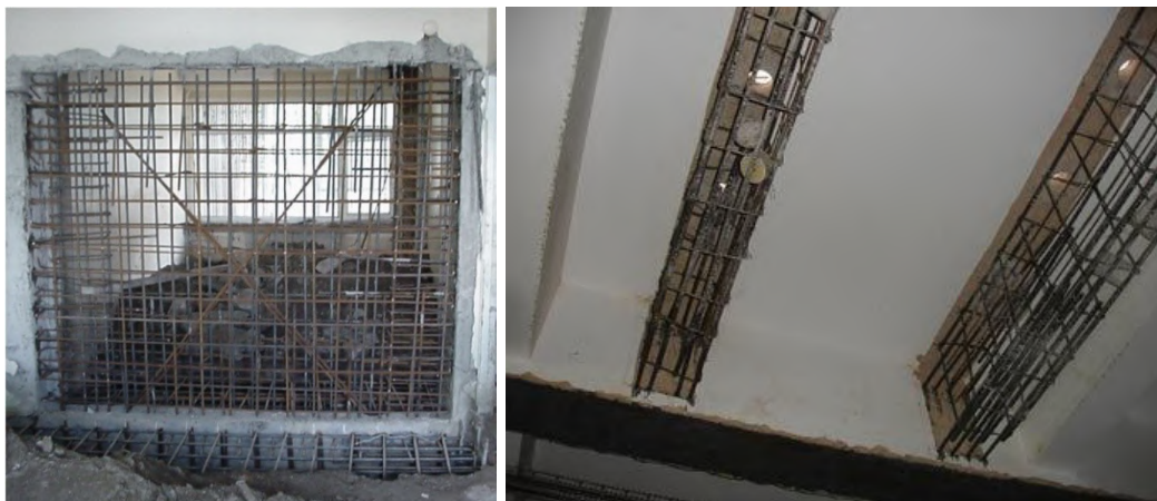
Figura 7. a) Reforço em parede de betão armado (fonte: Especial Reabilitação 2008 - Arte e Construção ) b) Reforço em viga de betão armado (fonte: https://www.tecnicas.com.br/ )
