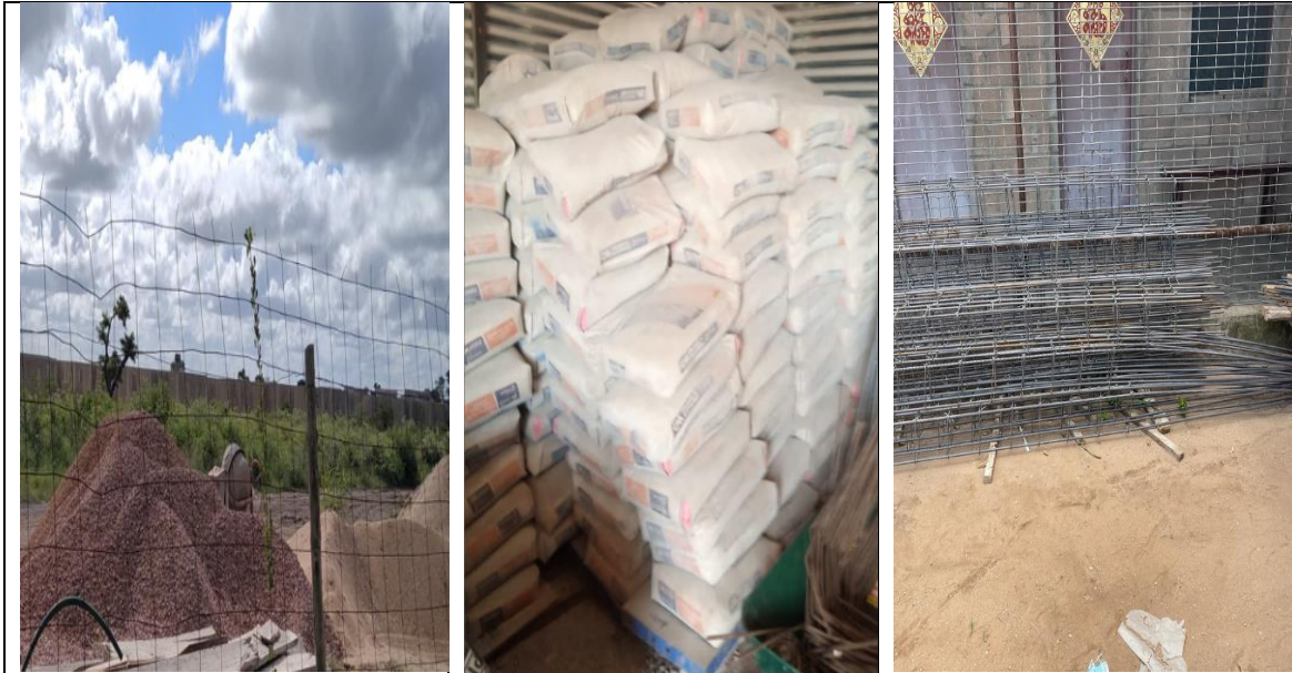
Figura-19: Armazenamento de inertes, cimento e aço. (Fonte: autor)
