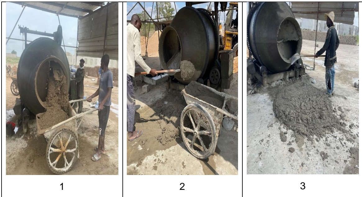
Figura-21: Produção de: 1-argamassa para blocos, 2-argamassa para assentamento de blocos e 3-betão. (Fonte: autor)
