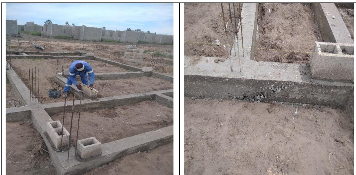
Figura-10: Execução da primeira fiada. (Fonte: autor)
