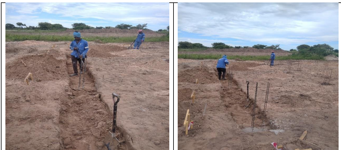
Figura-6: Abertura de caboucos manualmente. (Fonte: autor)
