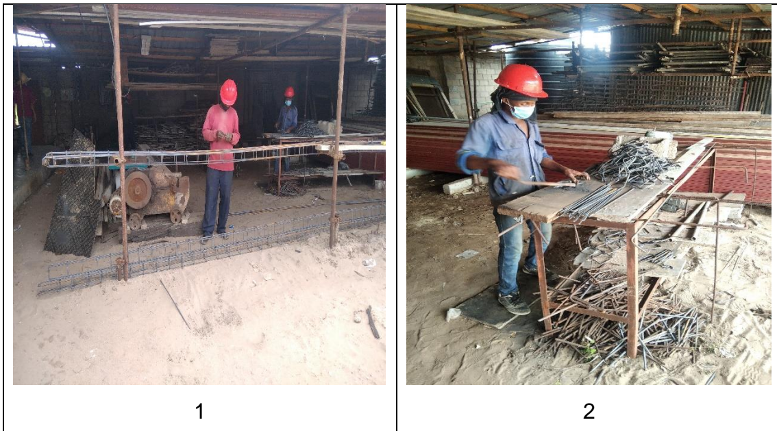
Figura-22: Produção de: 1- armadura para pilares e 2- estribos. (Fonte: autor)
