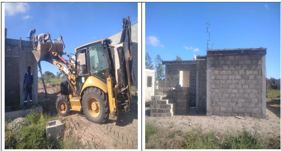
Figura-18: Betonagem de vigas. (Fonte: autor)
