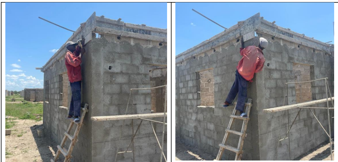
Figura-17: Cofragem da viga de coroamento. (Fonte: autor)
