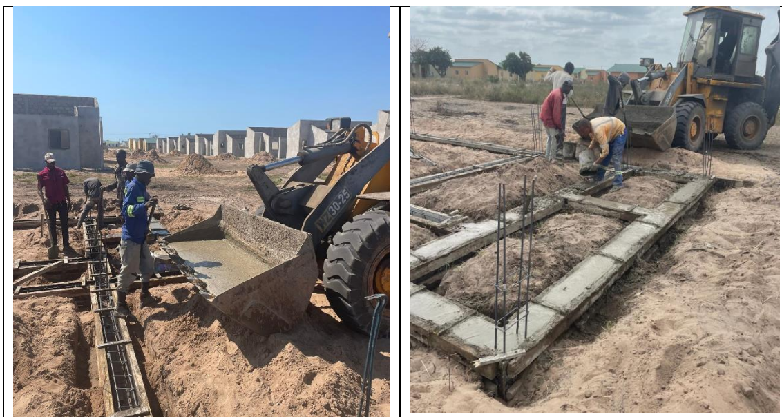
Figura-9: Betonagem das vigas de fundação. (Fonte: autor)
