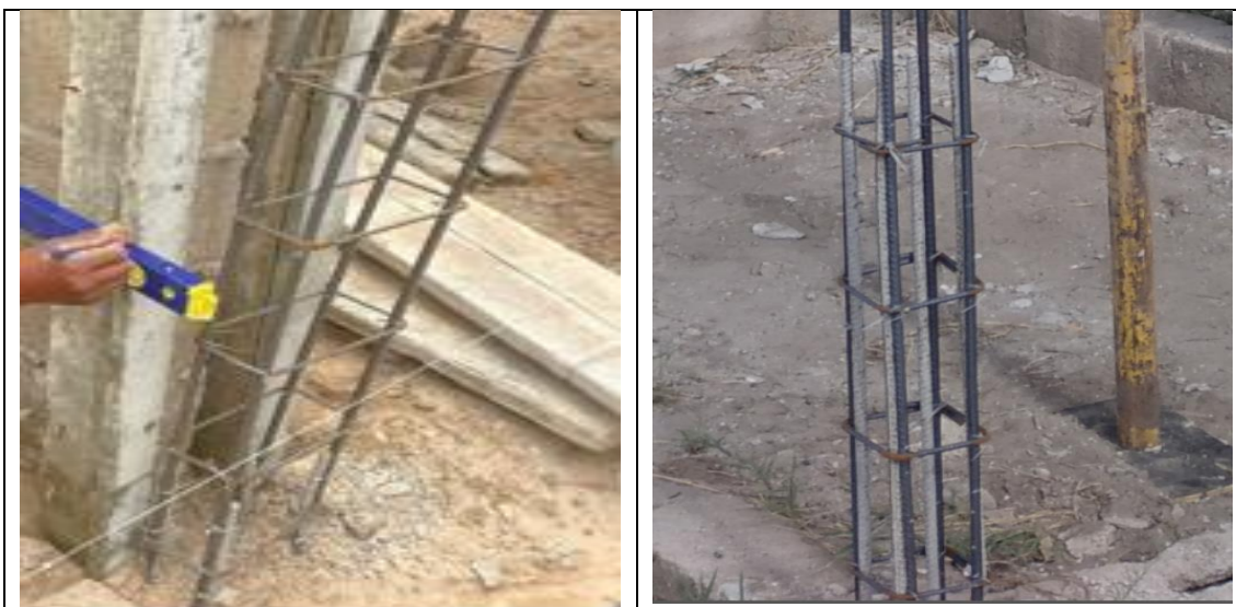
Figura-13: Empalme da armadura com arranque do pilar. (Fonte: autor)
