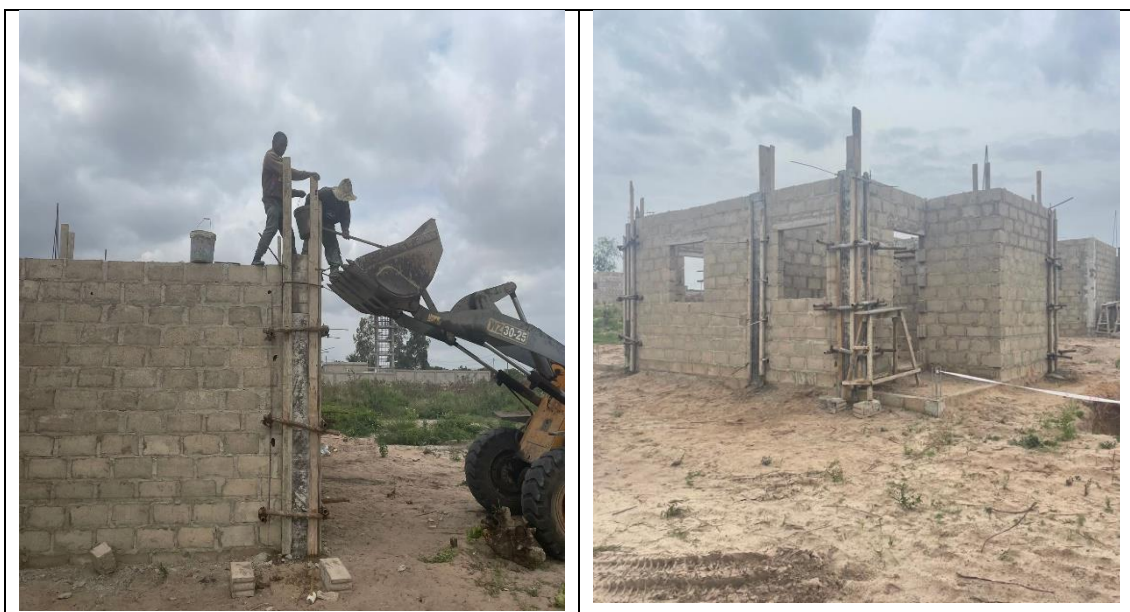
Figura-15: Betonagem dos pilares. (Fonte: autor)
