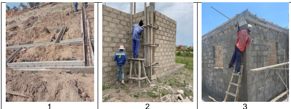
Imagem 26: 1-Cofragem da viga de fundação, 2-Cofragem do pilar e 3- Cofragem da viga de coroamento. (Fonte: autor)
