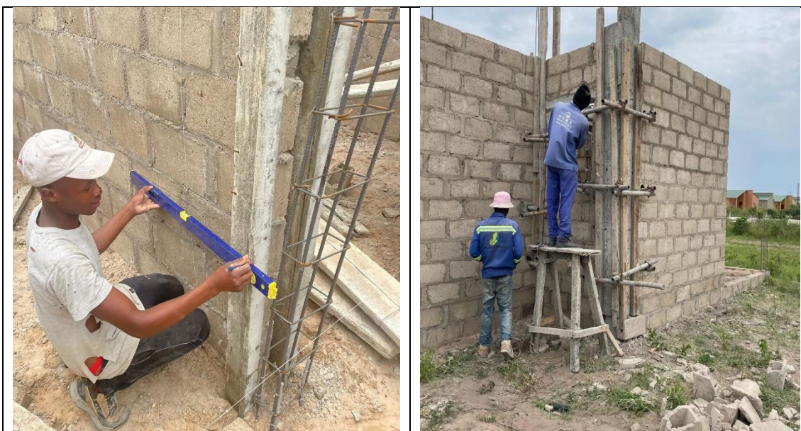
Figura-14: Cofragem dos pilares. (Fonte: autor)
