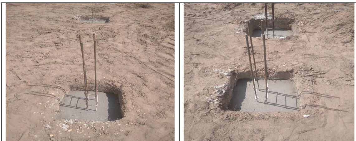
Figura-24: Implantação dos pilares. (Fonte: autor)
