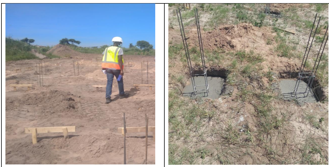
Figura-12: Marcação dos pilares. (Fonte: autor)
