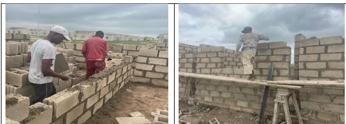
Figura-11: Execução das paredes em alvenaria. (Fonte: autor)
