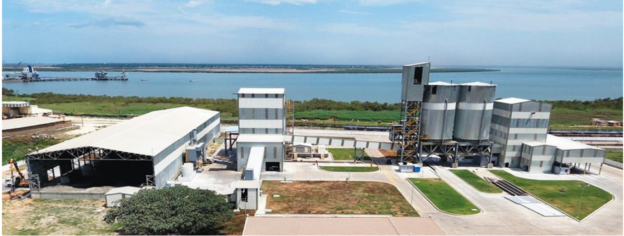
Figura 2. Fábrica de Cimento em estudo. Fonte (website oficial)
