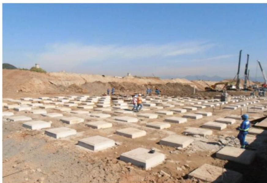
**Figura A1-5 – Instalação de capitéis**
