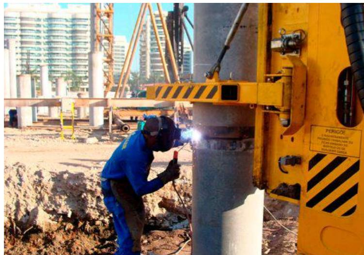
**Figura A1-4 – Soldagem de emenda entre estacas pre moldadas de betão**
