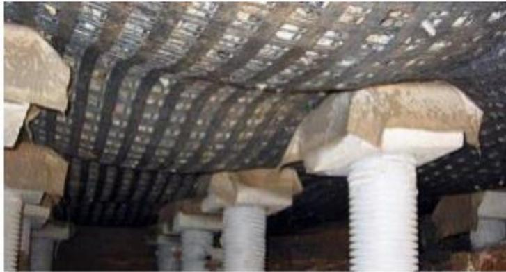
Figura 2- 6 – Vista de um aterro estaqueado com reforço de geossintético.
