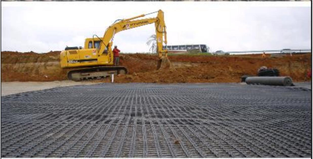
**Figura A1-6 – Instalação do geossintético**
