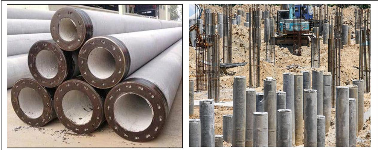
**Figura A1-3 – Estacas pre moldadas de betão**
