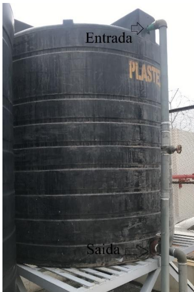
Figura 15-Disposicao dos tubos nos reservatórios de sucção
