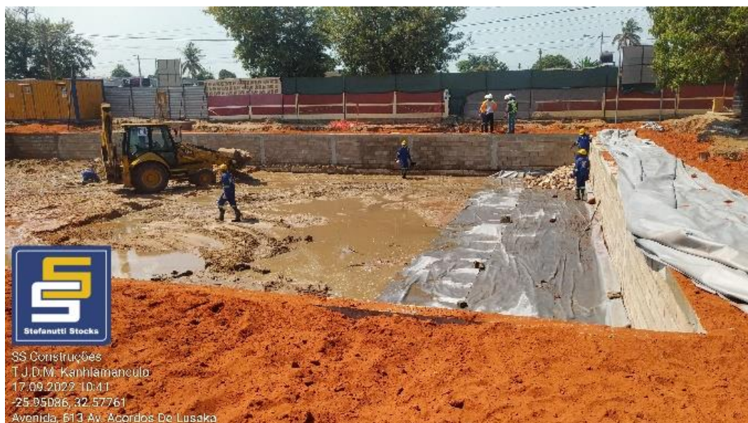
Figura 6 : Assentamento da primeira camada de mata Geotêxtil
