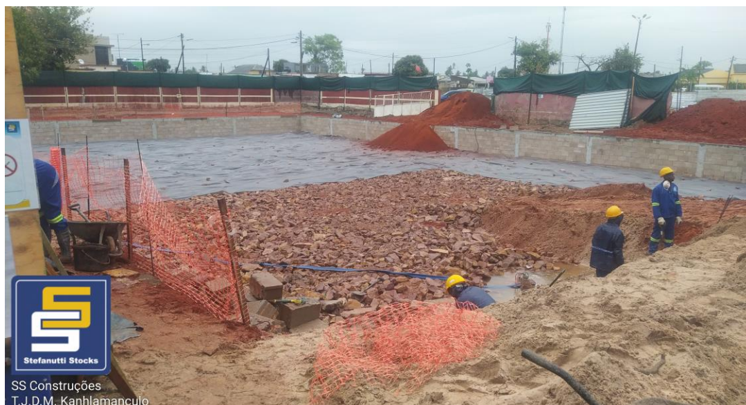
Figura 8 : Assentamento da segunda camada de Manta Geotêxtil
