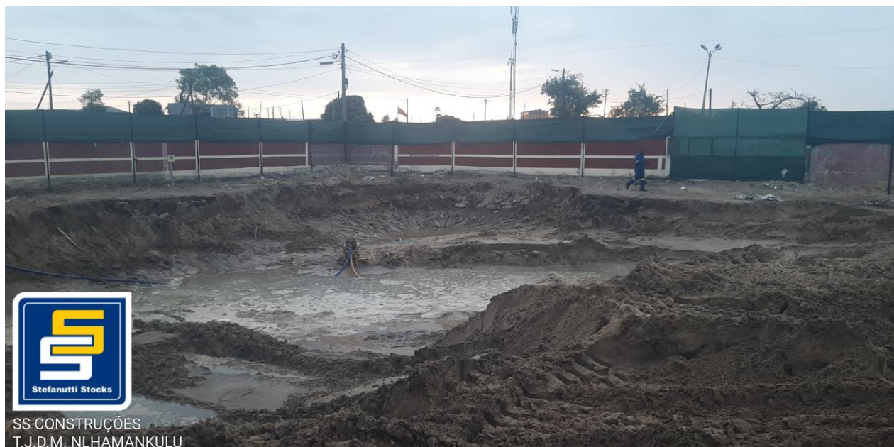
Figura 4: Bombagem da água da escavação para vala de drenagem
