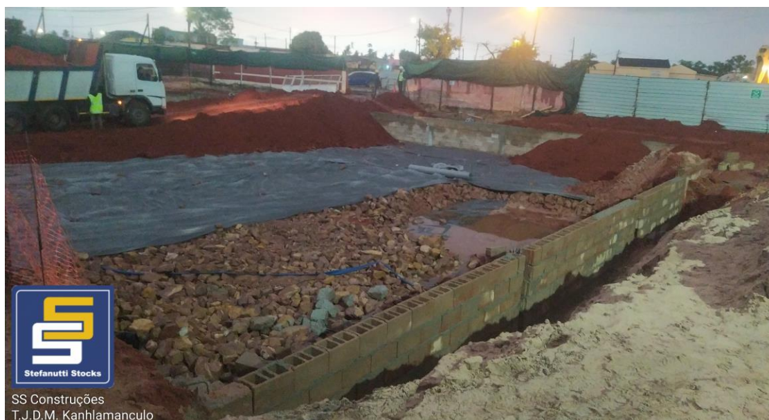
Figura 9 : Preparação da primeira camada do aterro
