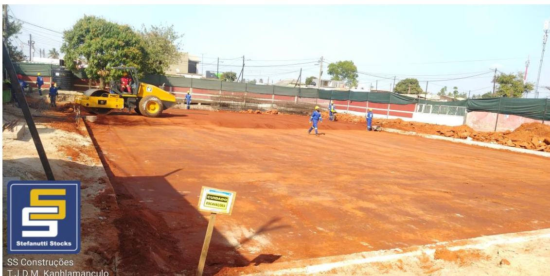
Figura 10 : Compactação através de um cilindro compactador
