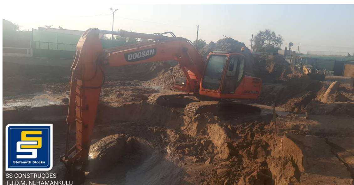
Figura 3 : Escavação com auxílio de uma Retroescavadora
