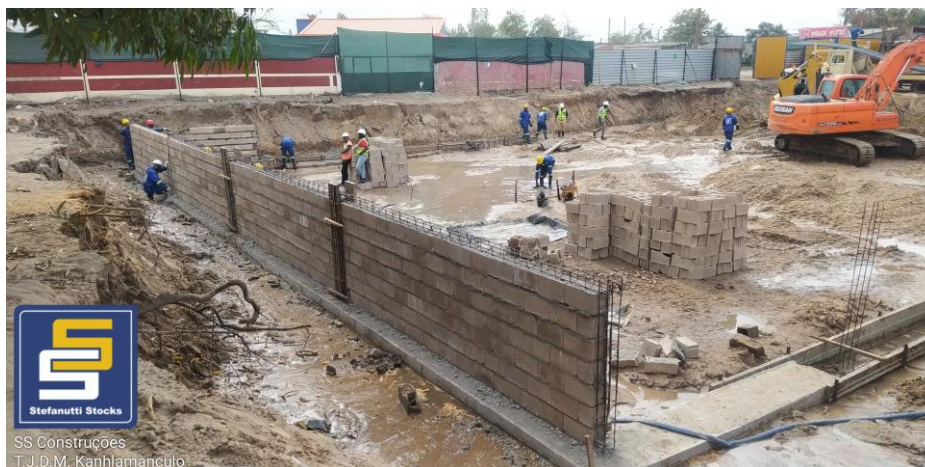
Figura 5 : Alvenaria do Muro de Contenção de Solos
