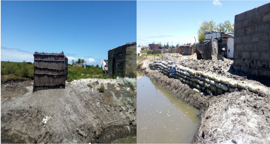
Figura 4. 3. Amontoamento de areia e sacos de matope como estratégia para defender da invasão das águas do mar no bairro do Costa do Sol.
