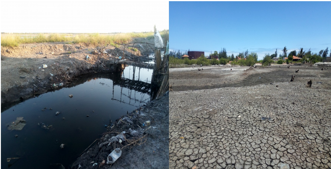
Figura 4. 4. Águas negras estagnadas no bairro do Lingamo e solo compactado no bairro do Costa do Sol
