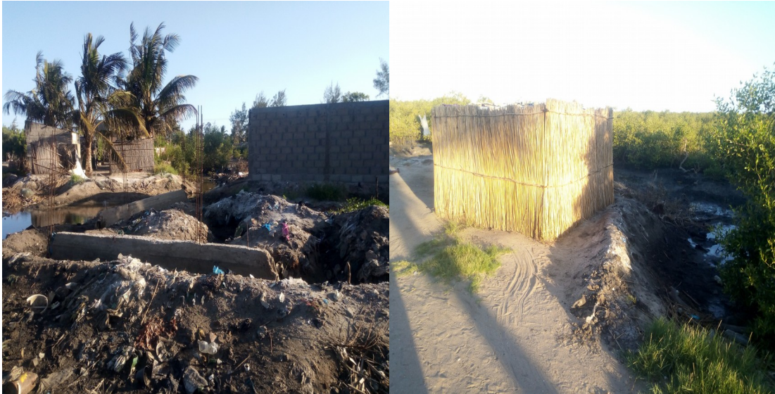
Figura 4. 2. Obras em construção no bairro do Costa do Sol.
