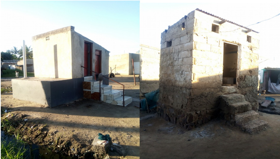
Figura 4. 5. Fossas de latrinas levantadas para cima.
