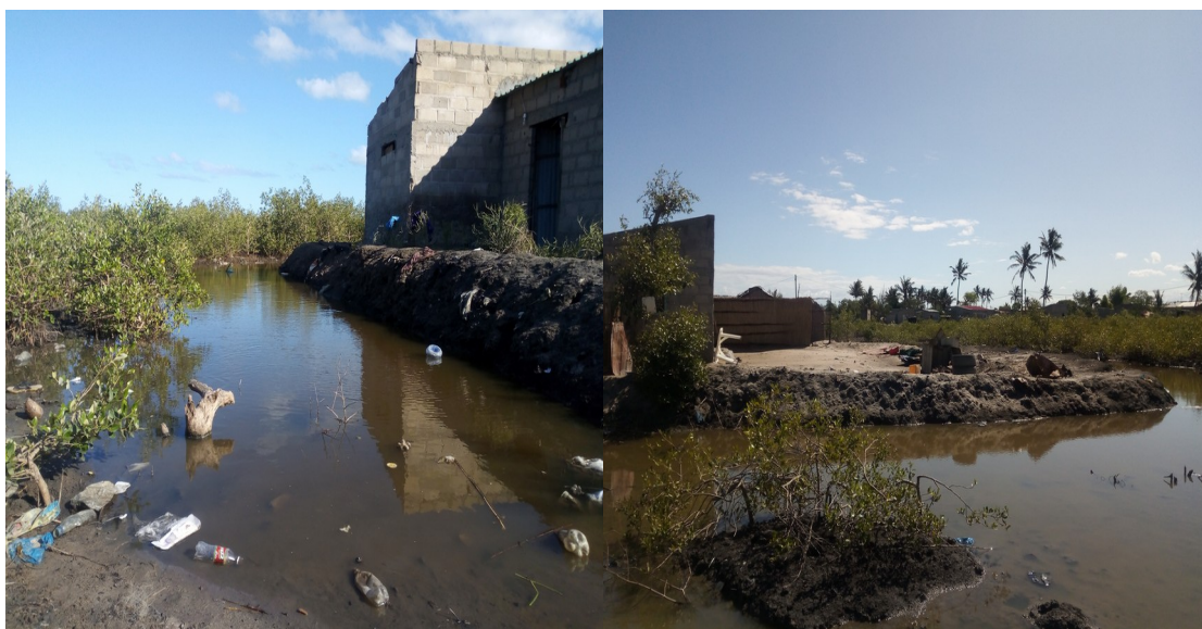
Figura 4. 1. Casas de moradias erguidas na vegetação do mangal no bairro do Costa do sol.
