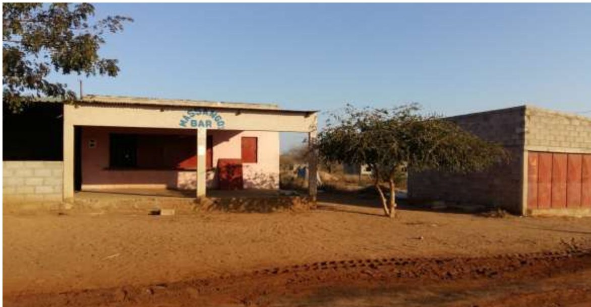
Figura: 6 Ilustra Infra-estruturas comerciais
