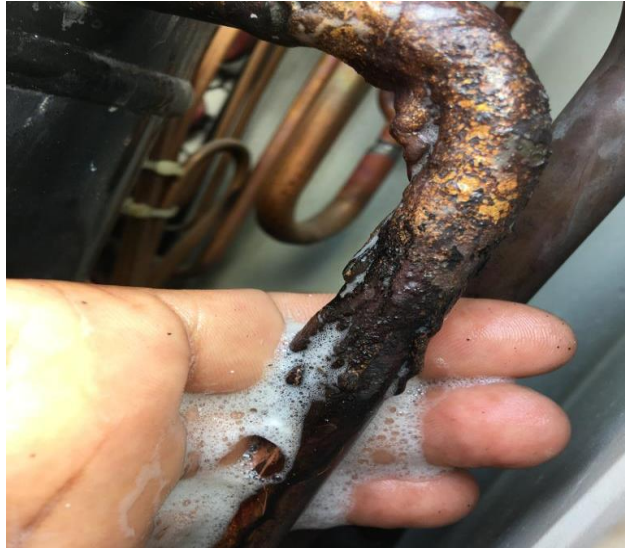
Figura 15-3: Verificação de eventuais fugas (Fonte: Autor)
