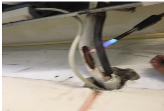
Figura 13-3: Eliminação de fuga por soldadura, EDM SE-11(Fonte: Autor)
