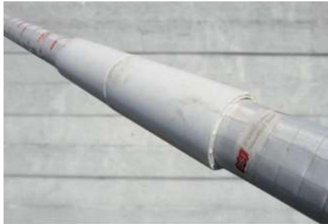
**Figura 17** - Sistema de protecção dos tirantes contra incêndio usando manta de protecção contra incêndio (material não inflamável e de baixa condutividade térmica) [7].
