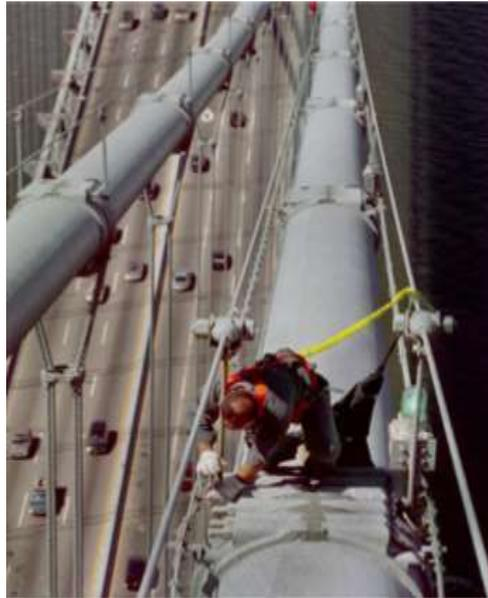
**Figura 20** - Uso de arnês de segurança para inspeção do cabo principal de uma Ponte Suspensa [15].
