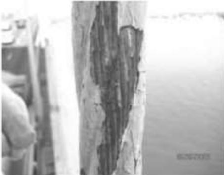
**Figura 29** - Exemplo de desgaste da pintura/revestimento ao longo do comprimento do pendural [4].
