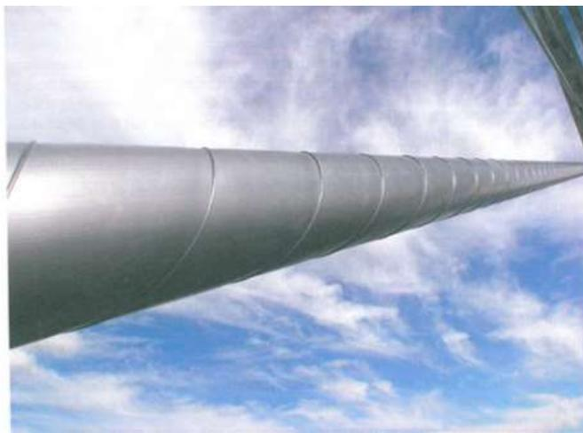
**Figura 12** - Tubo de cabo com nervuras helicoidais [12].
