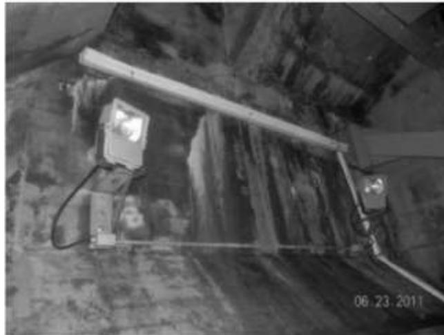
**Figura 36** - Vista típica de infiltração de água para o interior do bloco de ancoragem [4].
