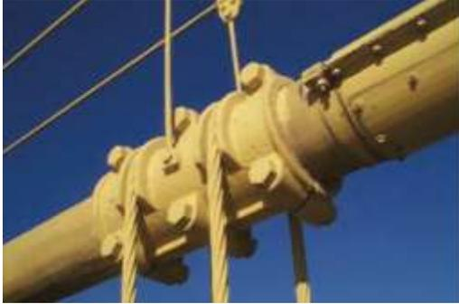
**Figura 2** - Ligação entre o pendural e o cabo principal por meio um anel de fixação (ou bandas do cabo principal) [18].
