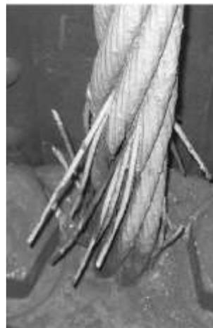
**Figura 31** - Exemplo típico de sinais de ruptura de fios na ligação pendural – tabuleiro [4].
