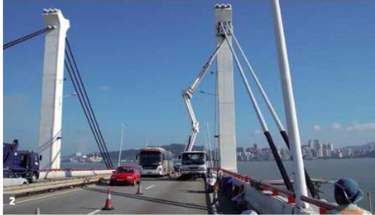
**Figura 25** - Acesso à zona de ancoragem dos cabos (mastros) através do camião tipo Munck [8].
