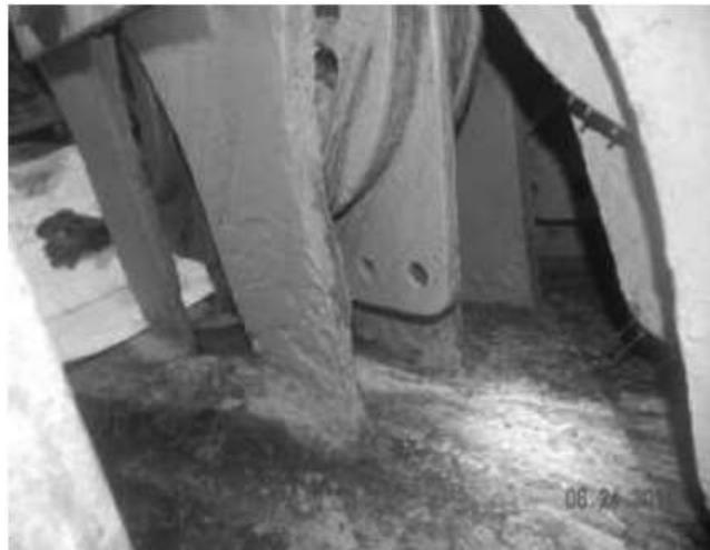
**Figure 35** – Exemplo de redução da secção da barra de ancoragem na interface entre a barra de ancoragem e o betão devido a corrosão [4].
