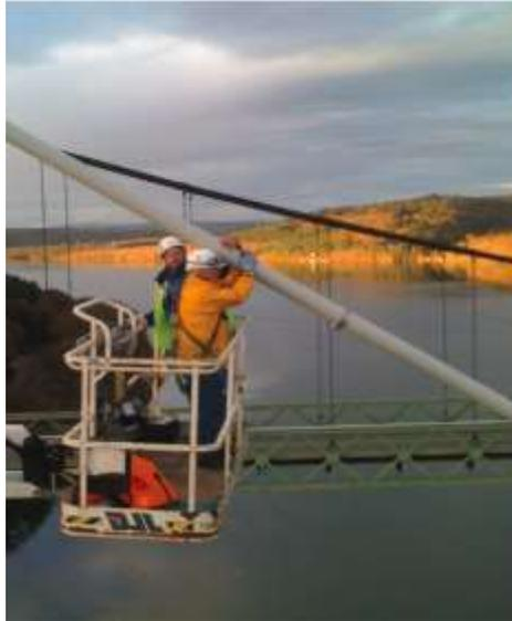
**Figura 23** - Acesso directo ao comprimento livre dos cabos usando o camião tipo Munck [8].
