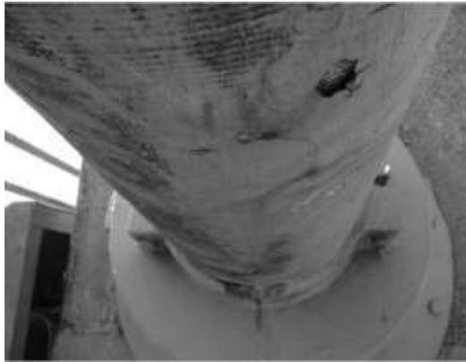
**Figure 27** - Degradação do revestimento do cabo principal [4].
