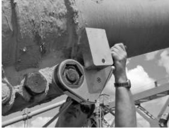
**Figura 33** - Chave de torque hidráulica para inspeção dos parafusos quanto ao torque [4].
