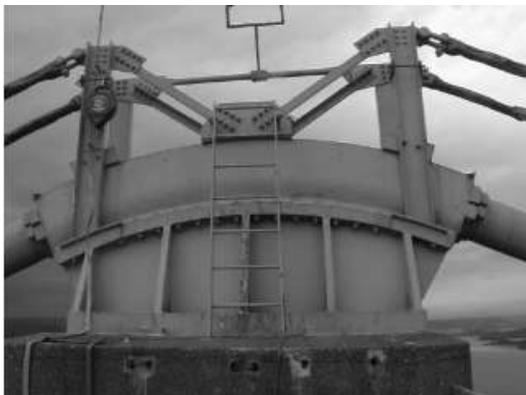
**Figura 5** - Sela para cabos principais de pontes suspensas [1].
