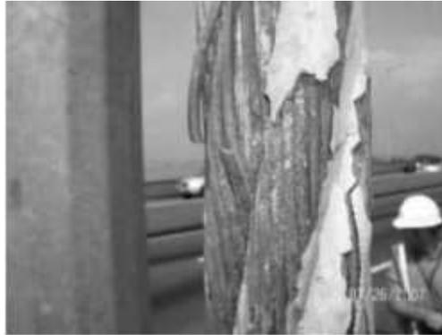
**Figura 32** - Exemplo típico de ruptura de fios e desgaste do revestimento ao longo do comprimento do pendural [4].
