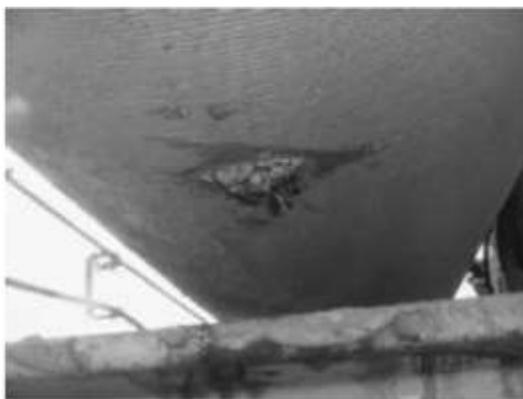
**Figure 26** - Perfuração do revestimento do cabo principal face a Infiltração de água para o interior do cabo principal [4].
