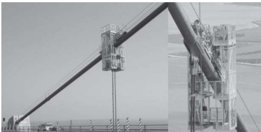
**Figura 21** - Transportador para inspeção ou manutenção de cabos principais para pontes suspensas [14].
