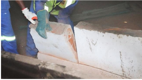
(a) Momento de recolha de amostra de parede na zona da cobertura para caracterização dos blocos
