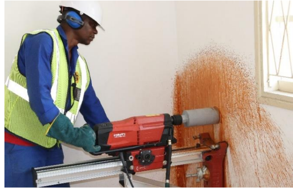
(b) Momento de extracção de carote no Q3 no piso do rés-do-chão
