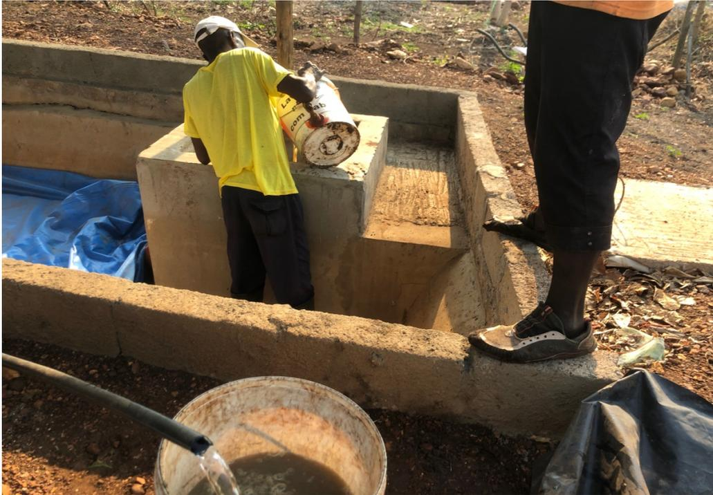
**Processo de alimentação do biodigestor**
