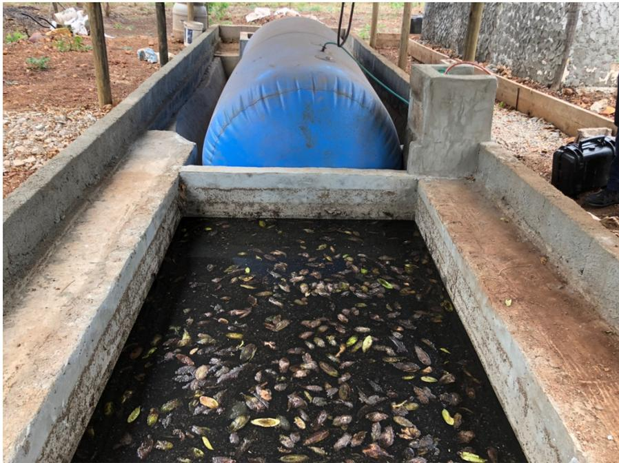
**Ilustração do balão no seu limite máximo de armazenamento**
