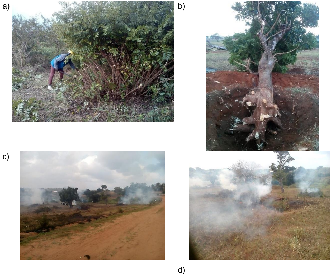
Figura 8: Remoção de obstáculos no terreno com recurso a ferramentas (alíneas a), b)) e com o fogo(alíneas c) e d))
