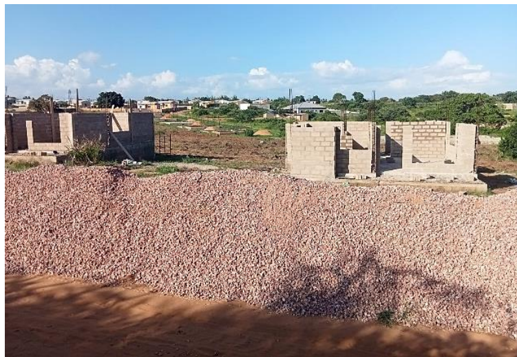
Figura 9: Estaleiro da obra
