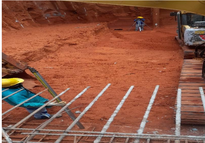
Figura 32 Marcação do nível com Dump Lever e Mira (Fonte: Autor)
