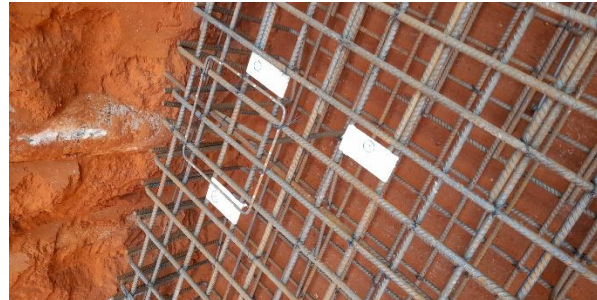
Figura 36.b – Pontos do pilar marcado (Fonte: Autor)
