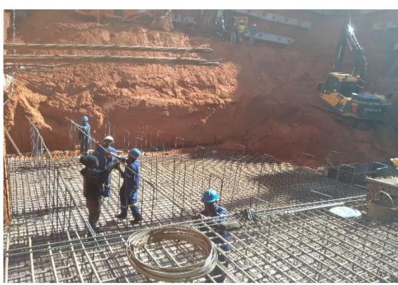
Figura 38.b – Amarração da malha superior(Fonte: Autor)
