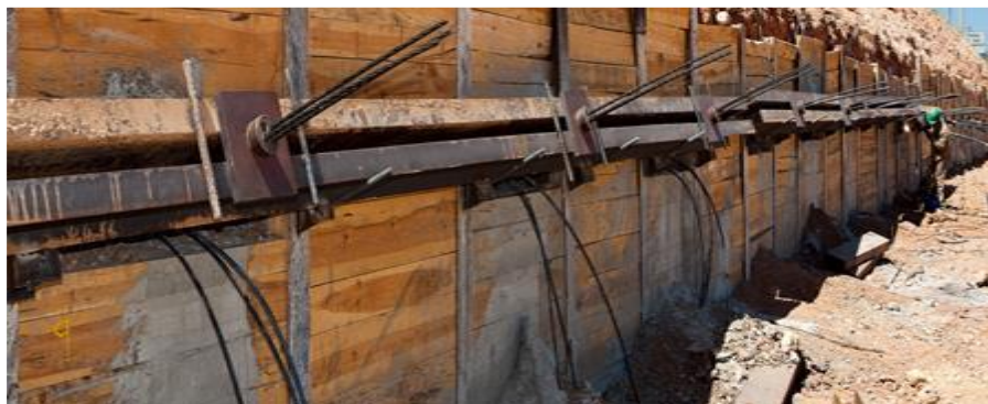
Figura 13 Paredes tipo Berlim (Fonte: INDUBEL, 2020).
