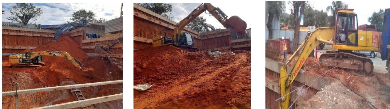
Figura 30 Processo de escavação(Fonte: Autor)
