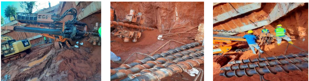
Figura 28 Máquina de perfuração(Fonte: Autor)
