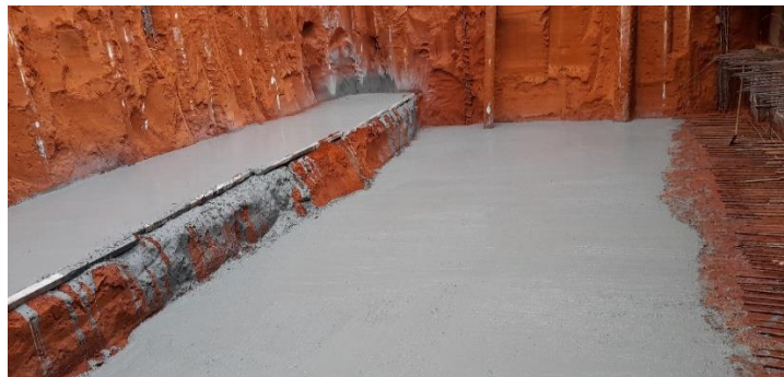
Figura 33 Betão de limpeza(Fonte: Autor)
