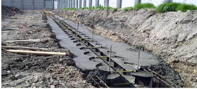
Figura 20 Execução de muros-guia (Fonte: Bessa Meireles, 2006)
