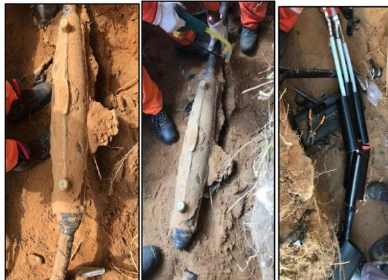
**Figura 38.** Remoção e instalação de uma nova caixa de junção subterrânea de MT [Autoria Própria]
