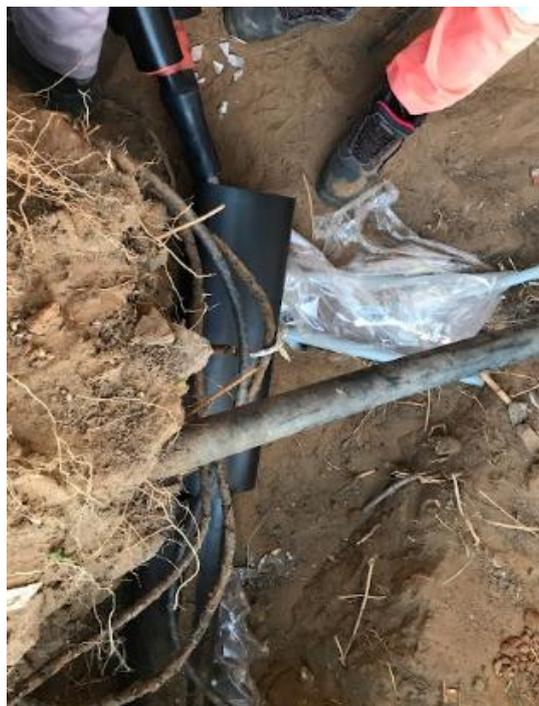
**Figura A6.2-6.** Execução uma caixa de junção subterrâneas [Autoria própria]
