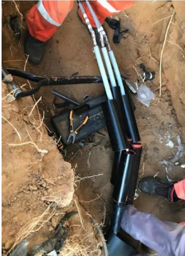
**Figura A6.1-6.** Execução de uma caixa de junção subterrâneas [Autoria própria]
