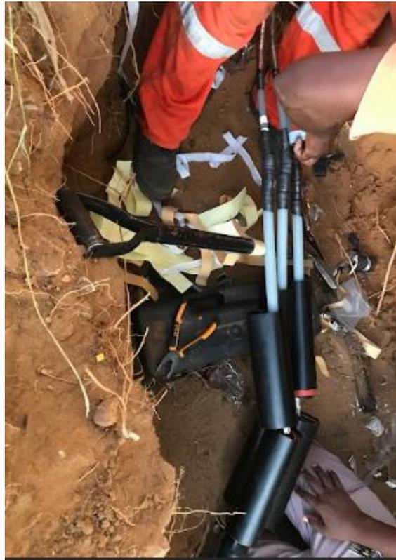
**Figura A7.1-7.** Execução uma caixa de junção subterrâneas [Autoria própria]
