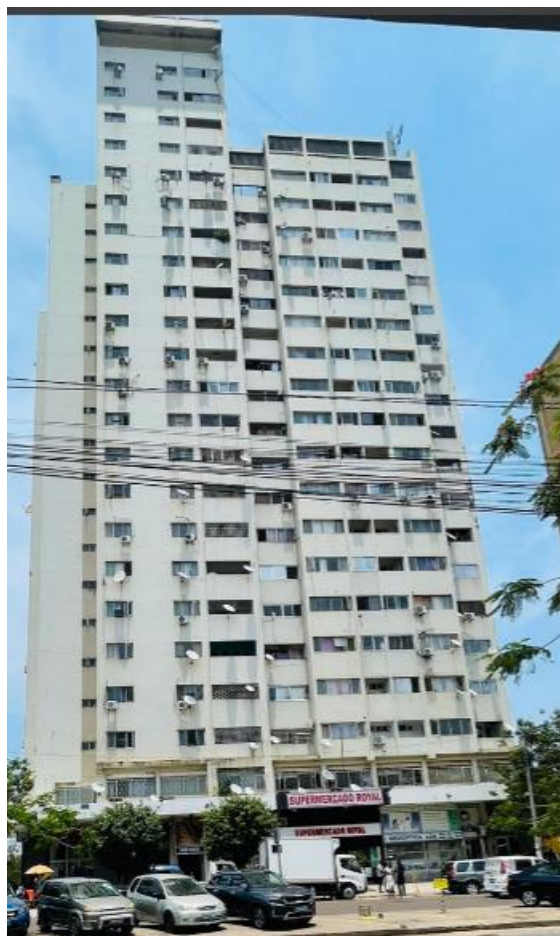
Figura 3.1. edifício do prédio de CFM, 24 de Julho cidade de Maputo.
