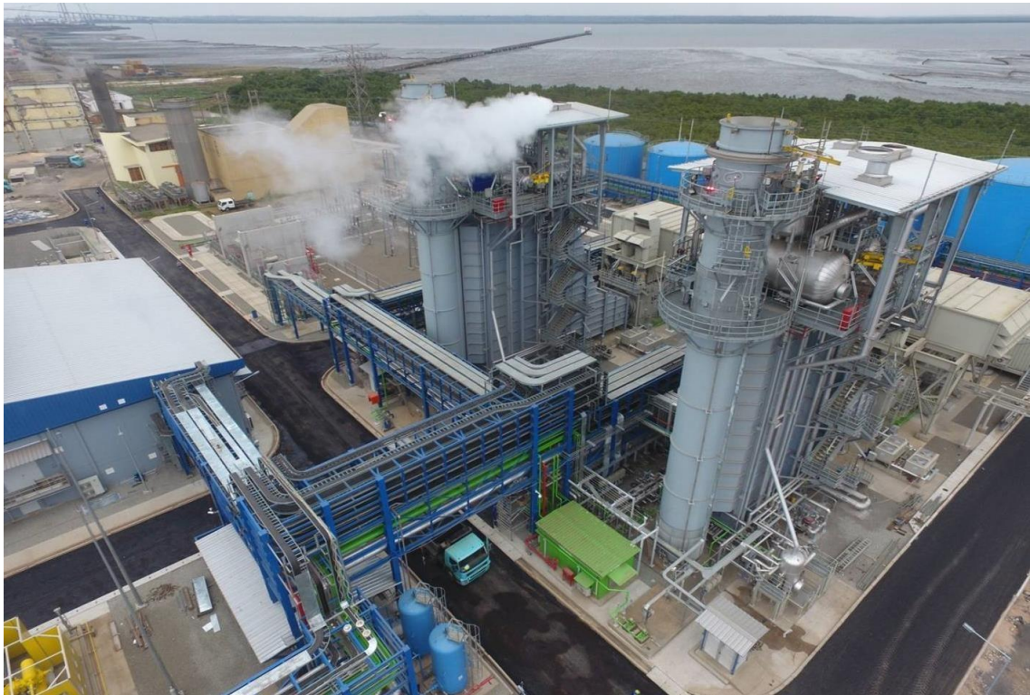
Figura 3.3: Central Termoeléctrica de Maputo – CTM [16]
