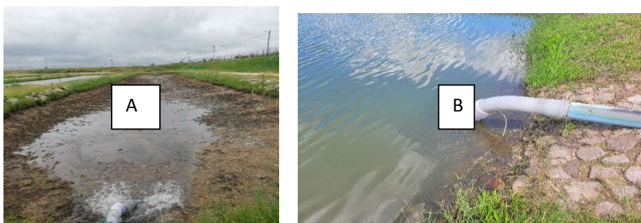
Figura II- (A) Enchimento do tanque, (B) Tanque Cheio
