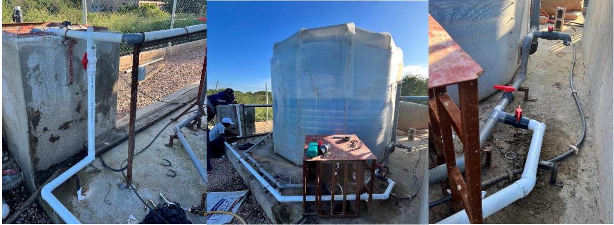
Figura A5-6: Montagem de sistema de limpeza.
