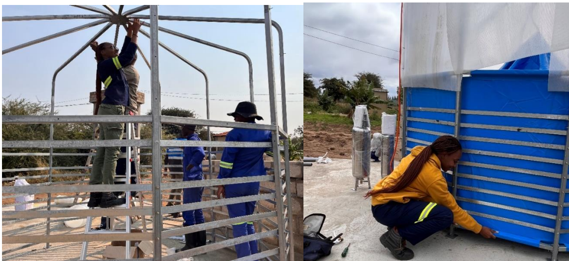
Figura A5-2: Montagem do biodigestor.
