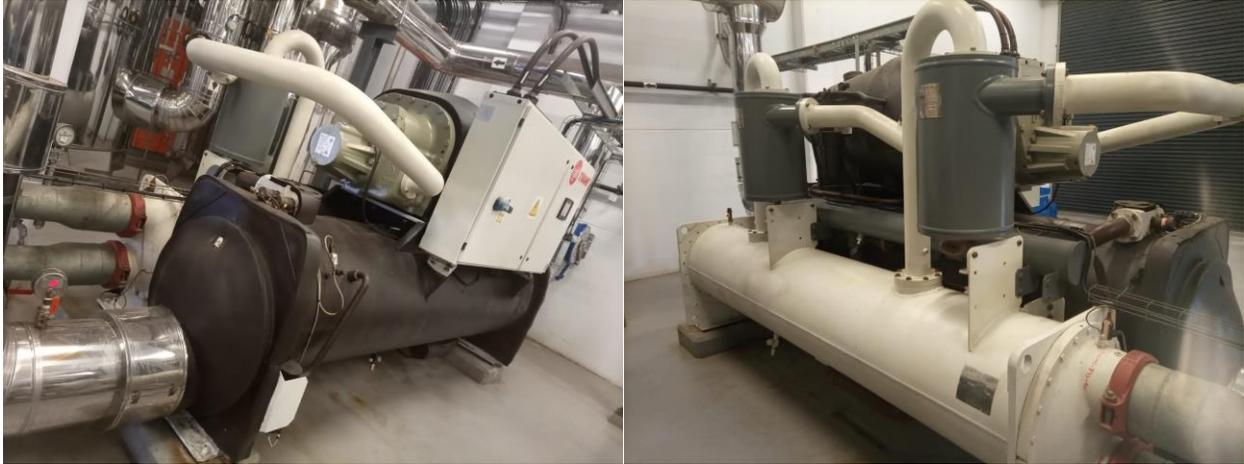
Figura 1 Chiller de parafuso.
