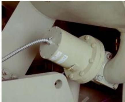
Figura 14 Válvula de expansão electrónica.
