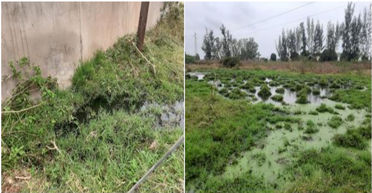
Figura7 e 8. Canais de saída de água residual para além dos muros da empresa
