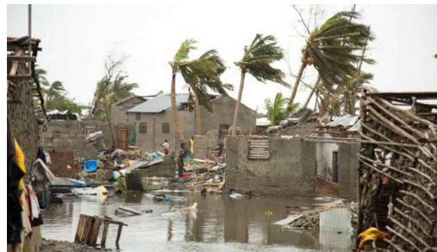
Fig.4-Destruição causada pelo ciclone Idai-Sofala Fonte: DW
