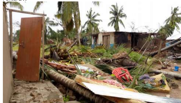
Fig.8-Destruição causada pelo ciclone Kenneth - Cabo Delgado Fonte: DW
