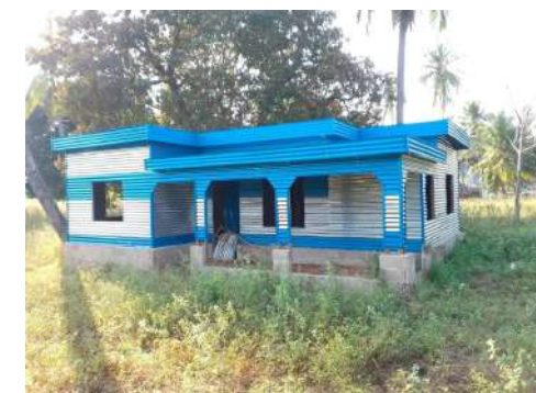
Fig. 56- Casa de Chapas de Zinco - Vilankulos Fonte: Autora
