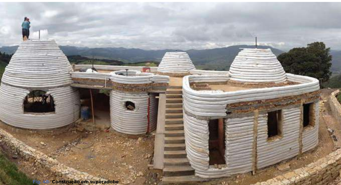
Fig. 49. Construção em superadobe
