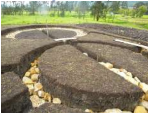
Fig. 41- Fundação (Fonte: Behance gallery)
