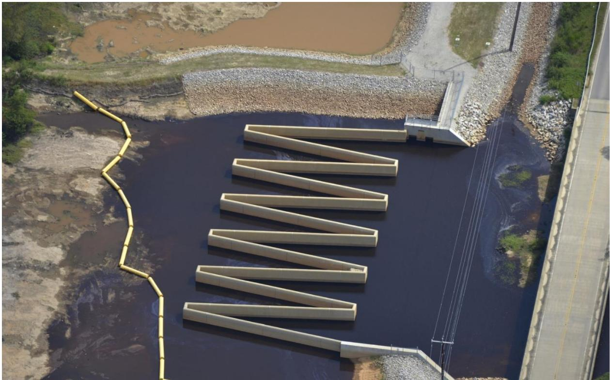
**Figura 1-** Descarregador em labirinto da barragem de Brazos, Texas, USA
