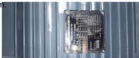
Figura 23-Chapa característica do motor do compressor
