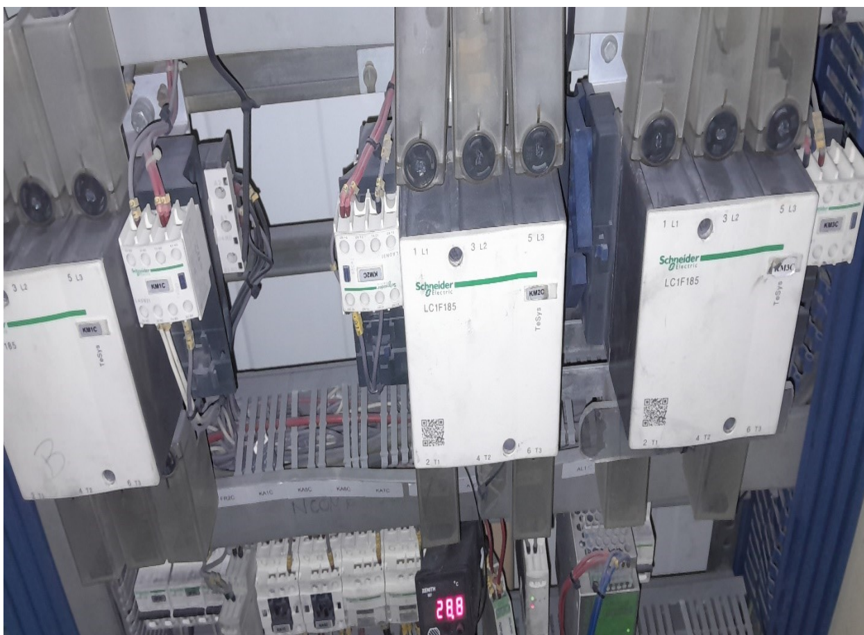
figura A5-10: Contactores eléctricos
